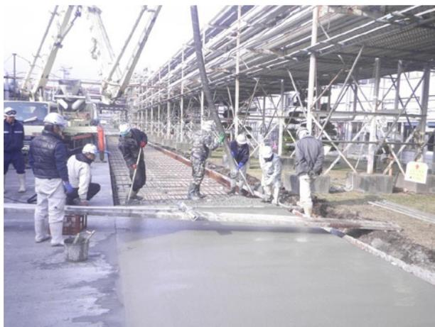
写真7 構内道路のコンクリート舗装状況
