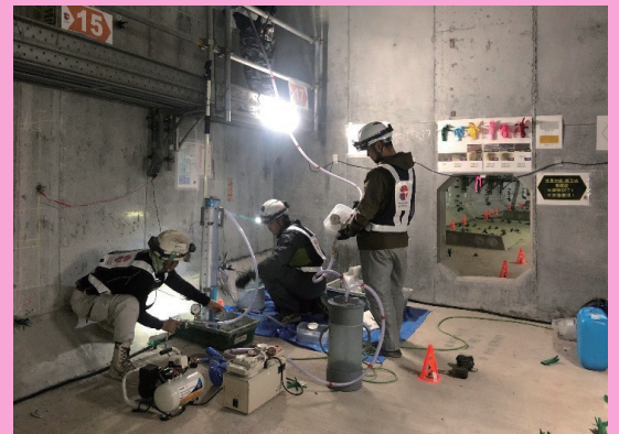
阪和自動車道土丸橋(上り線)のPCグラウト再充填工事
