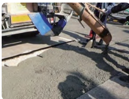
都道 : 目地部補修
