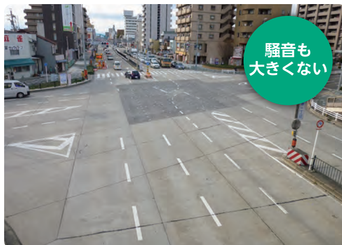
中心市街地にコンクリート舗装（国道1号）
