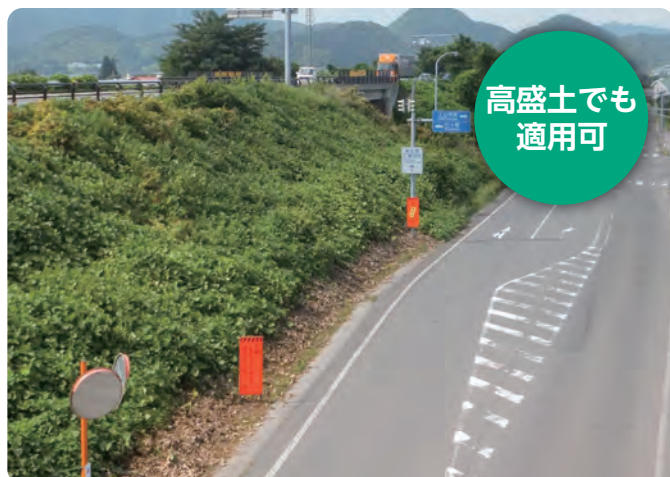
高盛土にコンクリート舗装（国道13号）
