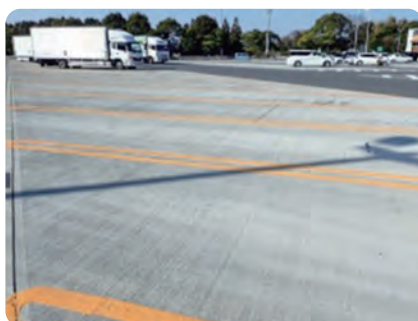
高速道路 : 大型車駐車桟打替え
