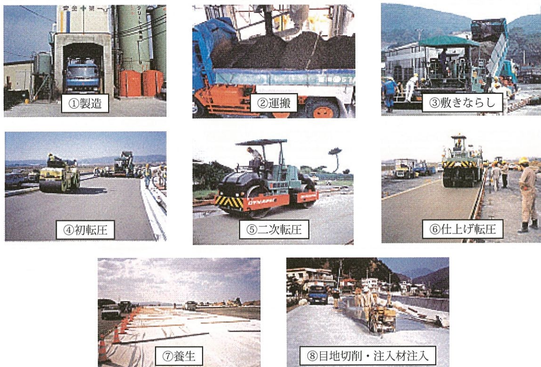
写真-1 高締固め型アスファルトフィニッシャを用いた転圧コンクリート舗装の舗設
