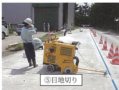
写真-1 簡易フィニッシャを用いた早期交通開放型コンクリート舗装の舗設
