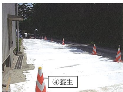
写真-1 簡易フィニッシャを用いた早期交通開放型コンクリート舗装の舗設
