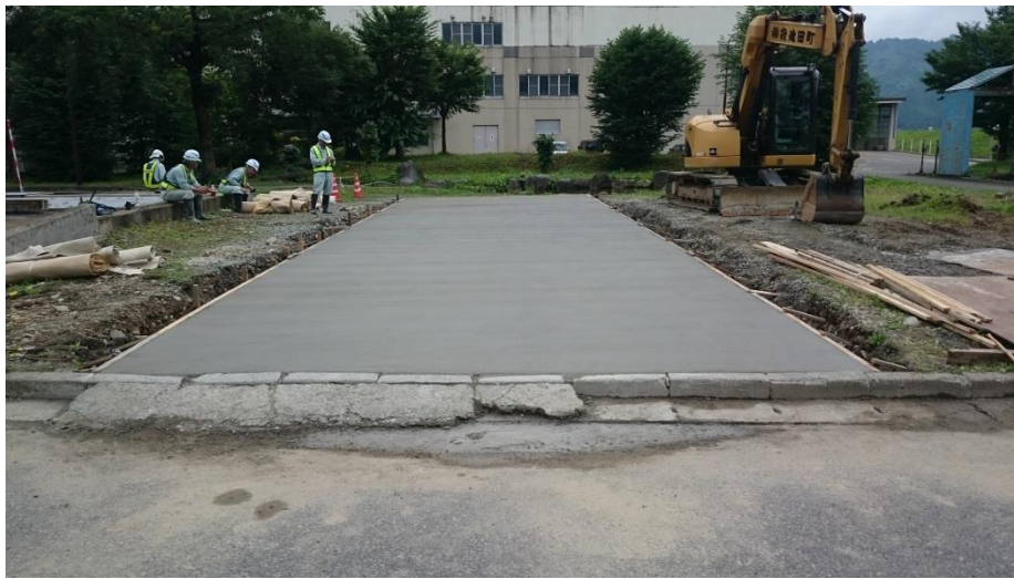
写真-14 施工現場
