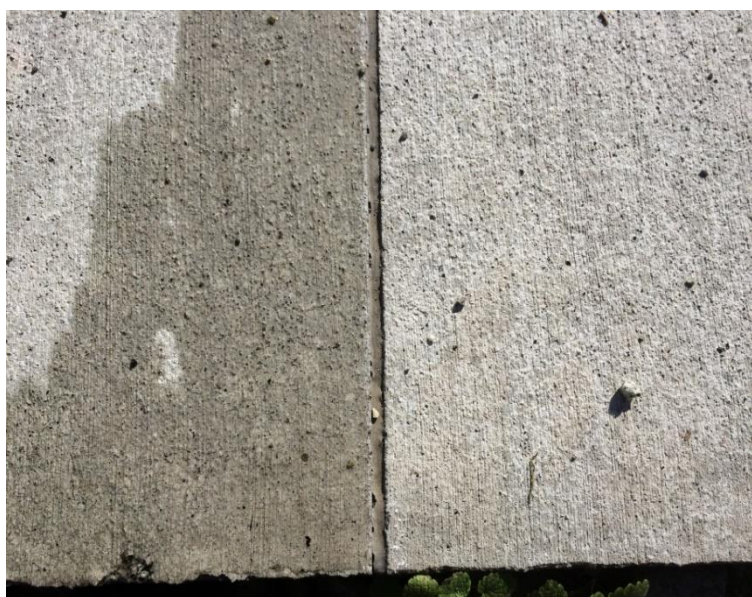
写真-18 施工現場 (供用中③)
