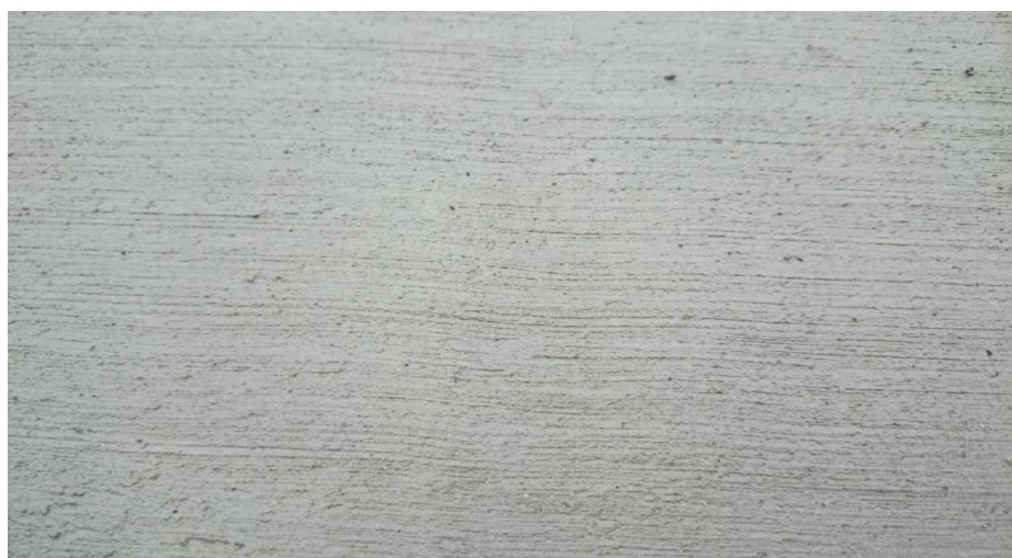
写真-12 仕上げ状況 (仕上げ③)
