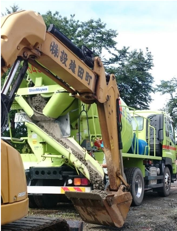
写真-6 施工状況
