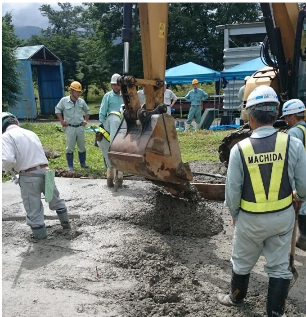
写真-7 施工状況
