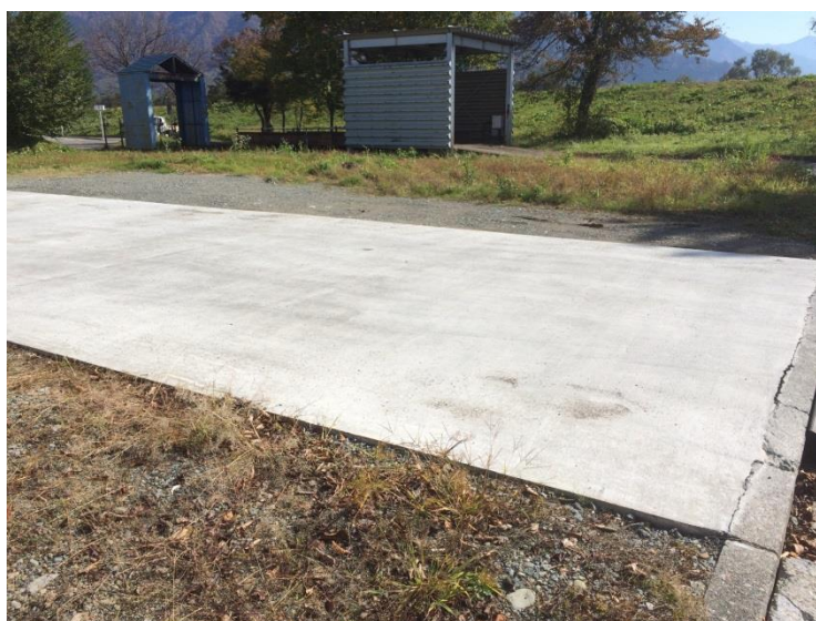
写真-17 施工現場 (供用中②)
