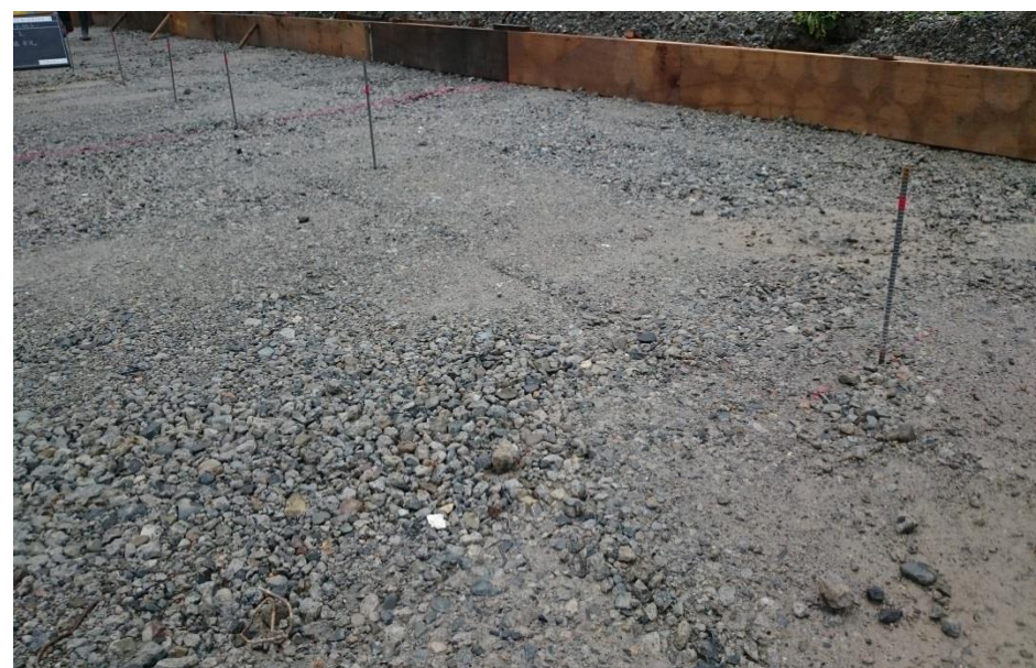
写真-2 施工現場 (施工前②)
