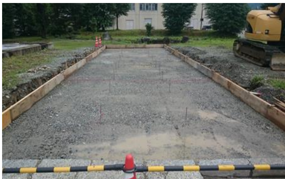
写真-1 施工現場 (施工前①)
