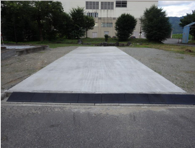
写真-15 施工現場
