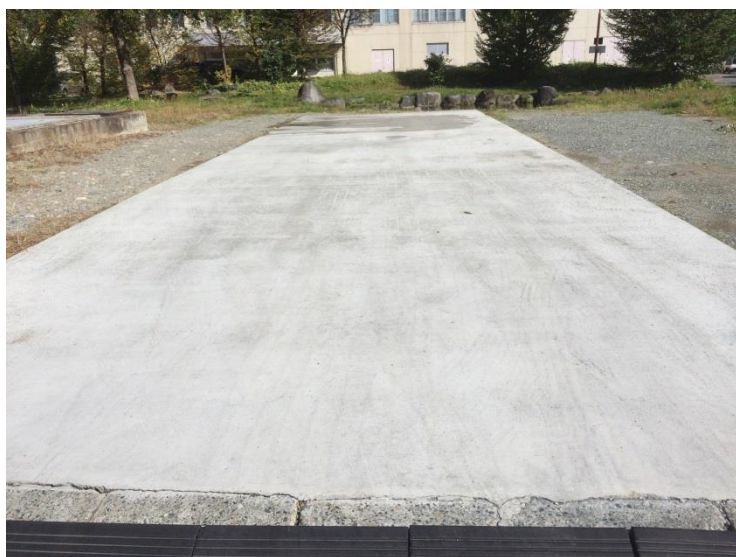
写真-16 施工現場 (供用中①)
