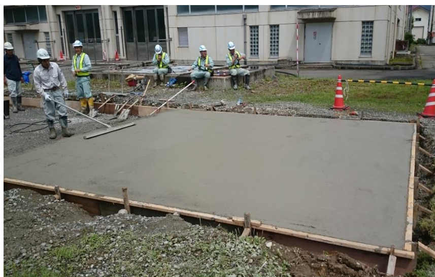
写真-9 施工状況
