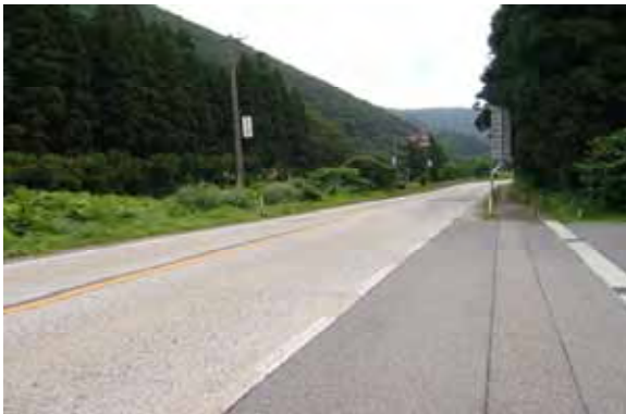
No.14、113号、新潟県関川村、供用25年
