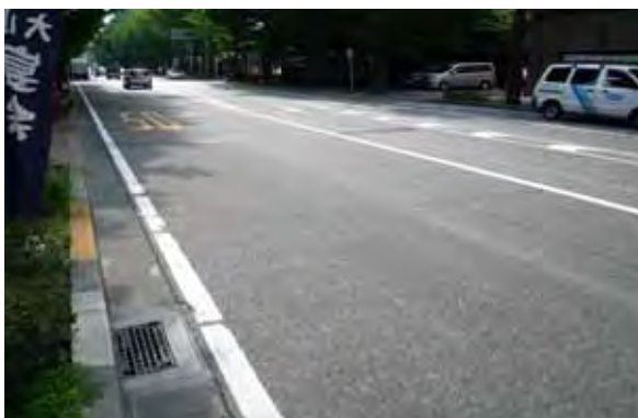
No.26、20号、東京都八王子市、供用50年
