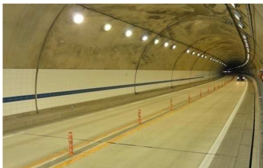
トンネル内はもちろんコンクリート舗装
