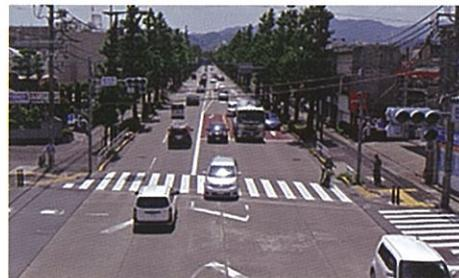
約50年間、大規模補修無しで供用している国道20号のコンクリート舗装区間(1962年施工)
