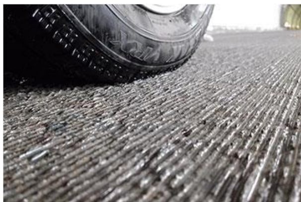
施工後のコンクリート路面の様子
