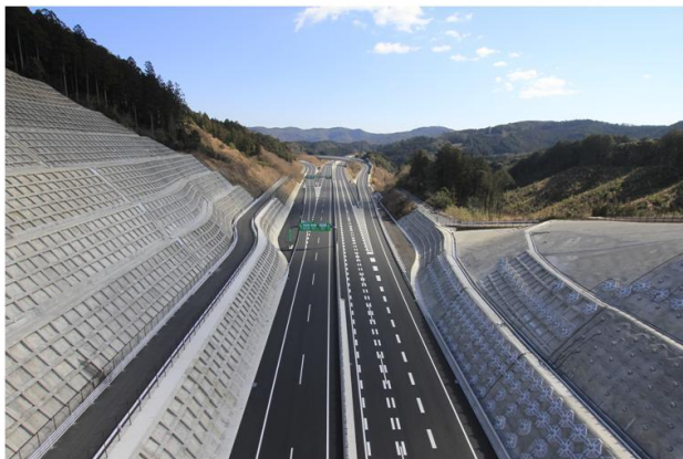
完成したコンポジット舗装(新城インターチェンジ)
