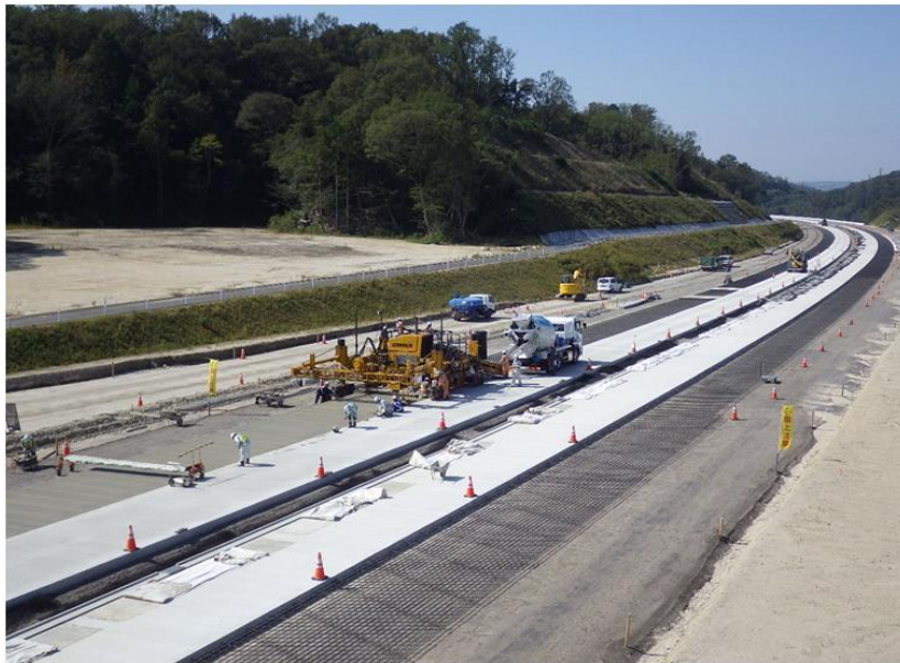
基層のコンクリート舗装部分を施工中
