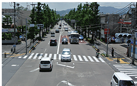
約50年間、大規模補修無しで供用している国道20号のコンクリート舗装区間(1962年施工)
