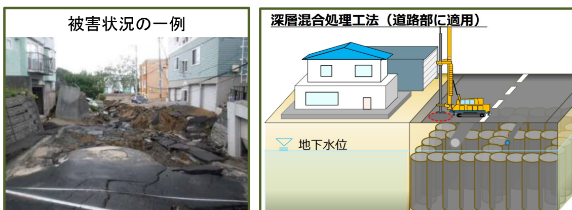
図5 液状化被害の状況と対策イメージ※7
