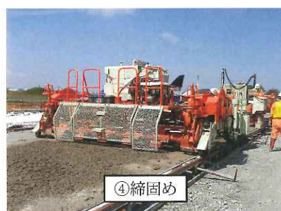
写真-1 セットフォーム工法による普通コンクリート舗装の舗設
