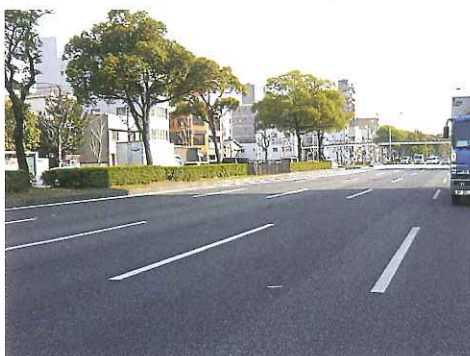
写真：RCCベースのコンポジット舗装
