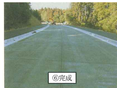
写真-1 アスファルトフィニッシャーを用いたポーラスコンクリート舗装の舗設（フルデプスタイプ）
