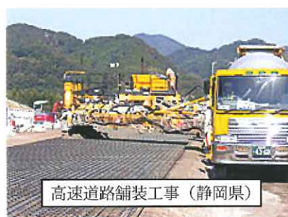
写真-1 連続鉄筋コンクリート舗装の施工状況
