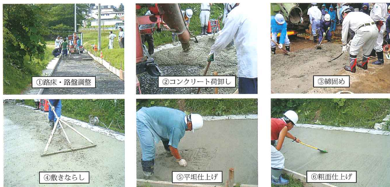
写真-1 人力施工による生コン舗装の舗設
