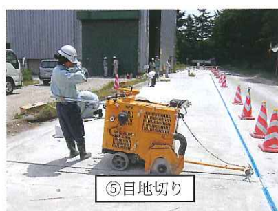
写真-1 簡易フィニッシャを用いた早期交通開放型コンクリート舗装の舗設
