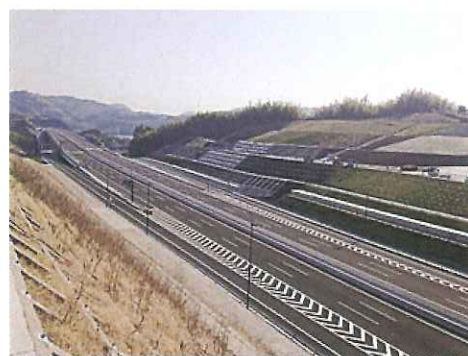
写真：CRCベースのコンポジット舗装 大成ロテック(株) HP より
