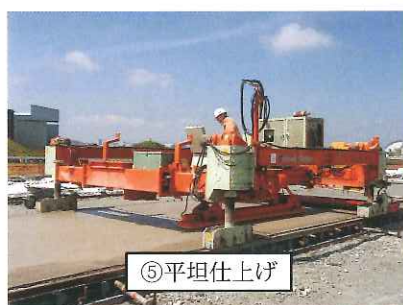
写真-1 セットフォーム工法による普通コンクリート舗装の舗設
