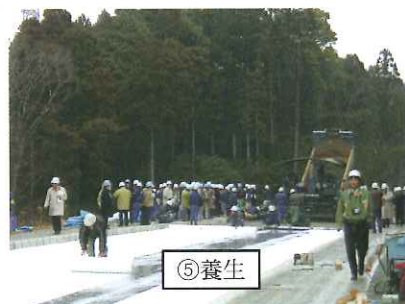
写真-1 アスファルトフィニッシャーを用いたポーラスコンクリート舗装の舗設（フルデプスタイプ）
