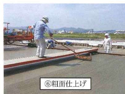
写真-1 セットフォーム工法による普通コンクリート舗装の舗設
