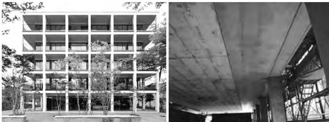
写真5 CO 2 -SUICOMのプレキャストパネルをバルコニー天井部に適用した例
