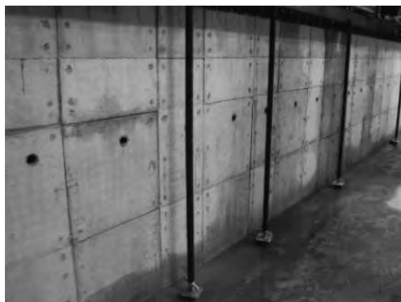
写真6 CO 2 -SUICOMの埋設型枠への適用例
