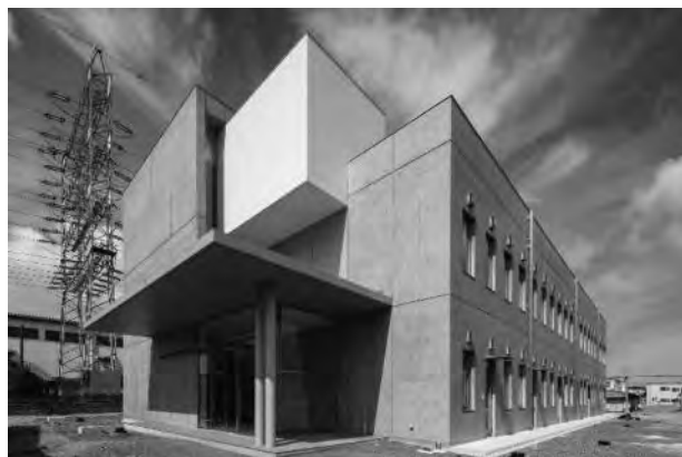
写真2 基礎419m 3 と高強度プレキャスト柱2本に適用した例 [日鉄高炉セメント本社；B0 F3 P0]
