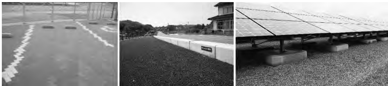
写真4 CO 2 -SUICOMを各種コンクリートブロック製品に適用した例
