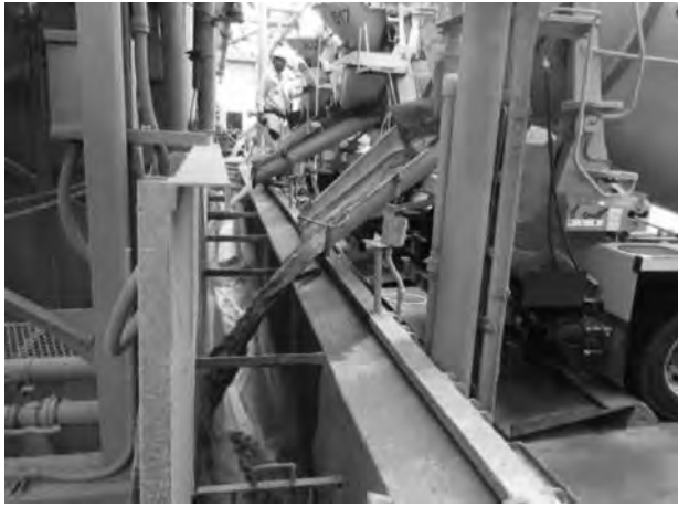
写真2 生コン工場で発生する残コン・戻りコン
