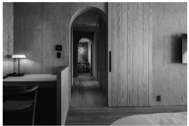
写真7 客室のRC現し [撮影：藤本一貴]
