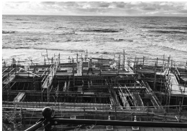
写真11 天候の変わりやすい海風の中での施工
