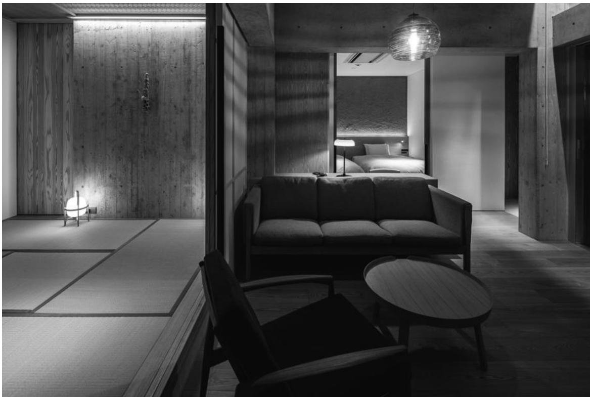
写真5 杉板型枠を床の間に見立てた和室 [撮影：藤本一貴]
