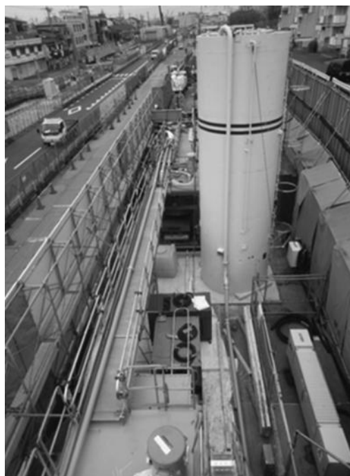
写真10 プラント設置状況
