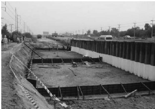
写真4 既設盛土掘削～型枠設置状況
