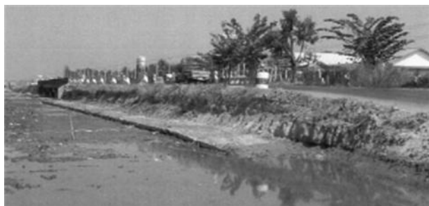
写真2 不等沈下によって折損したスラブ
