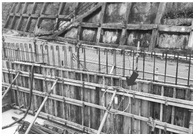
写真10 型枠に設置された温度センサー(矢印)
