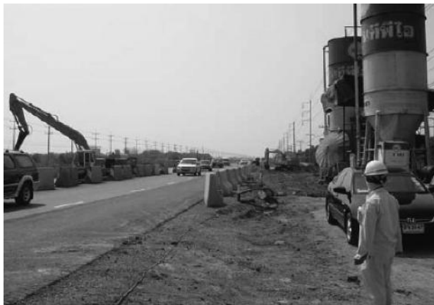
写真9 舗装完了後の交通開放と2期施工状況
