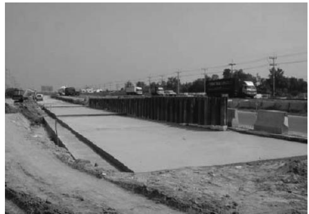
写真7 気泡混合土打設完了
