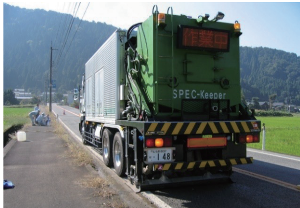
写真4 ウォータージェットの状況
