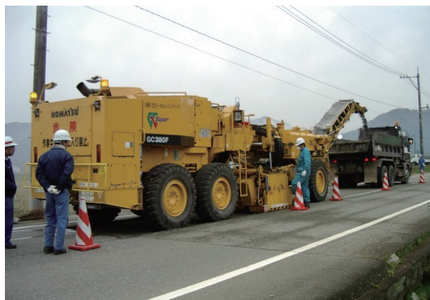
写真5 既設ポーラスコンクリート切削
