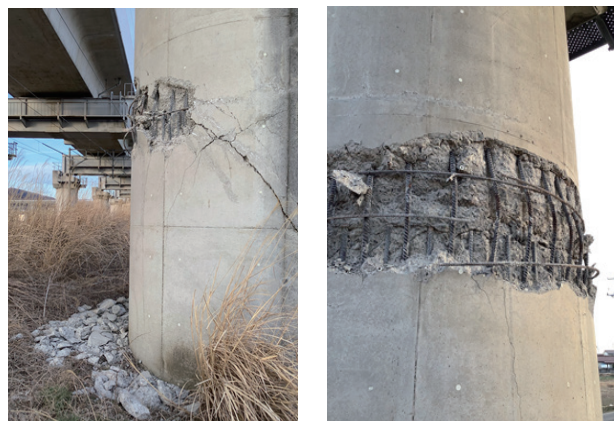
(a)全景 (b)鉄筋の途中定着部 写真7 被災状況
