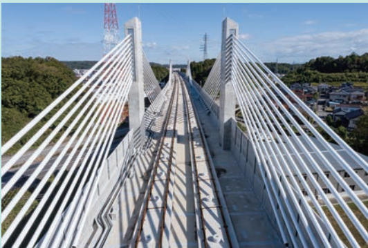
新幹線の橋りょうにおいて国内最長スパンとなったエクストラドーズド橋《北陸新幹線 細坪高架橋の施工》
