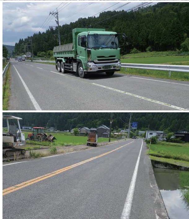
写真1 供用20年における試験施工個所の状況 [上：大野，中：今庄，下：今立]
