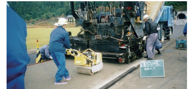
写真3 ポーラスコンクリートの打設状況
