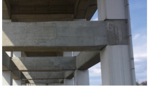
写真6 中層梁の復旧完了状況
