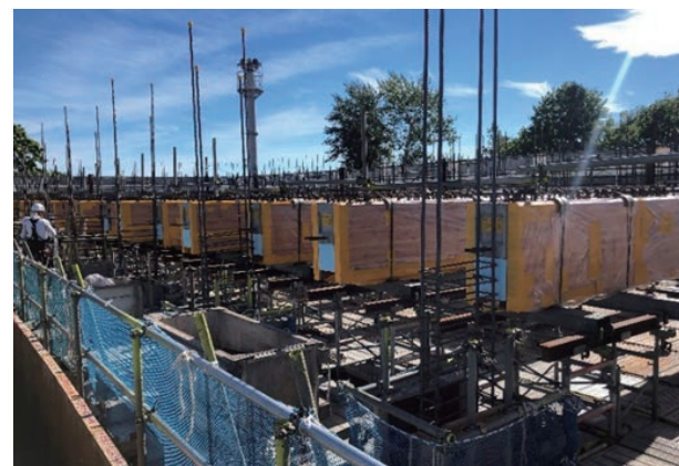
写真6 TW-PC梁の架設状況
