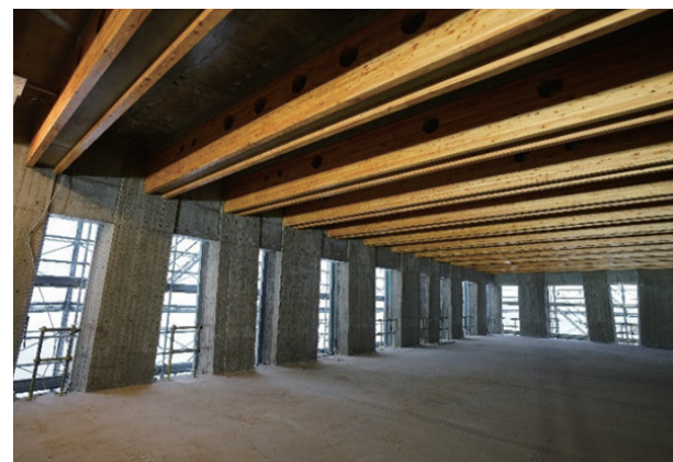
写真7 施工完了時のTW-PC梁
