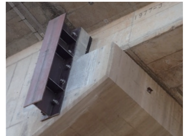
写真2 応急復旧状況
