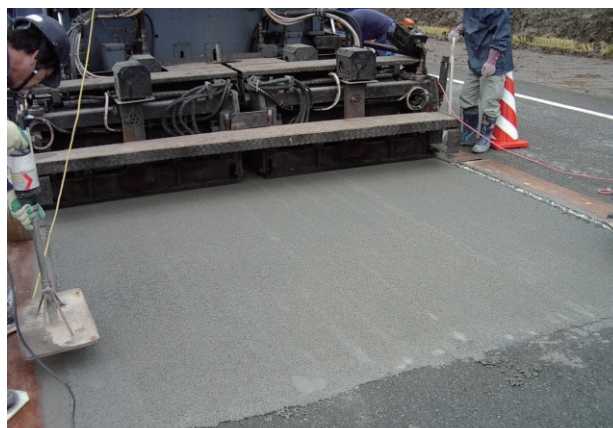
写真8 ポーラスコンクリート打設
