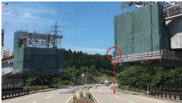
写真4 国道8号との離隔状況
