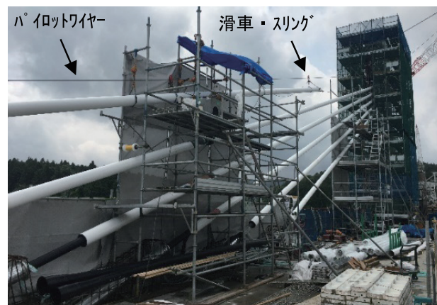
写真7 斜材保護管施工状況
