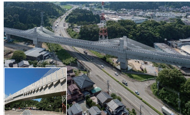
写真1 細坪架道橋全景
