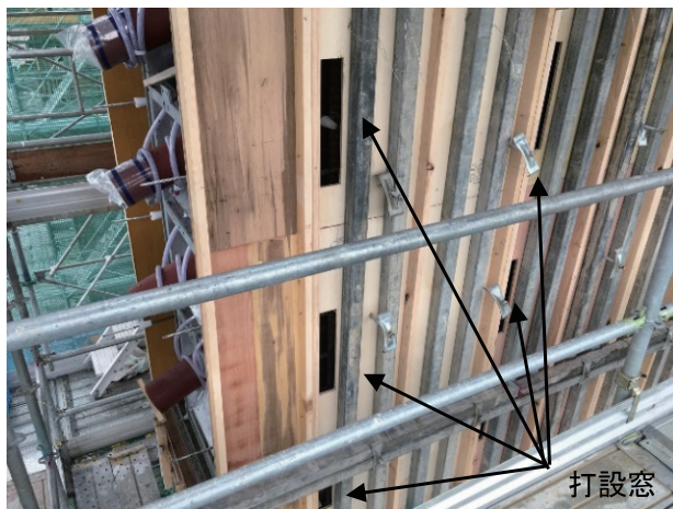
写真6 主塔サドル部型枠状況(側部から)
