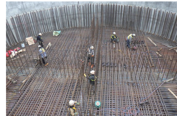
写真3 頂版鉄筋施工状況
