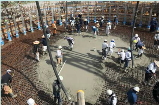
地上式LNGタンクのコンクリート施工における温度ひび割れ防止と暑中コンクリート対策《沖繩電力(株)牧港ガスエンジン発電所新設工事》
