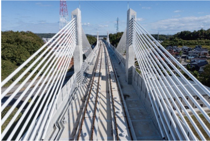
写真8 細坪架道橋完成状況(橋面)
