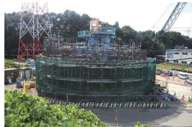
写真2 ケーソン施工状況
