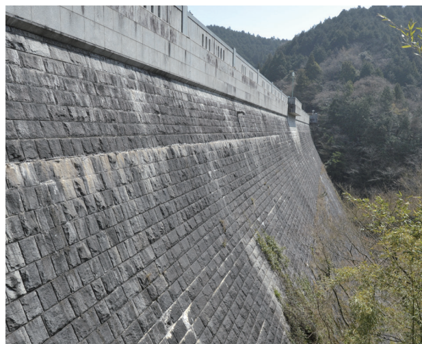
粗石コンクリート造+表面に御影石布積による堤体
