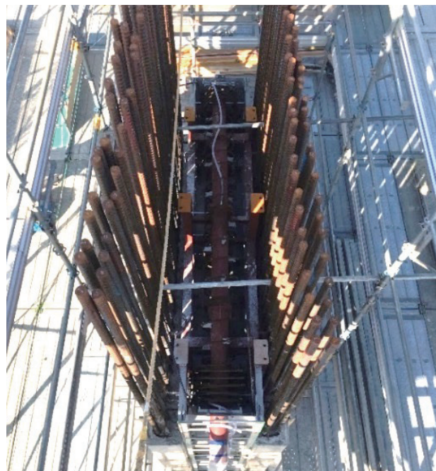
写真5 主塔サドル部配筋状況(上部から)
