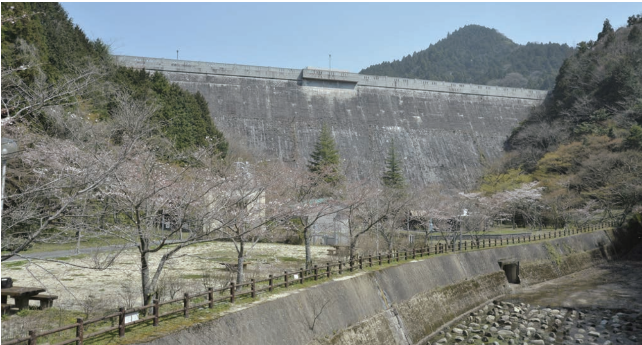
〔写真：上左〕御影石が敷かれた天端部通路 〔写真：上中〕ダム左岸の洪水吐は自然越流 〔上右〕左岸に置かれた碑には「天源豊」と読むことができる 〔写真：下〕下流に整備された「曲淵ダムパーク」は桜の名所
