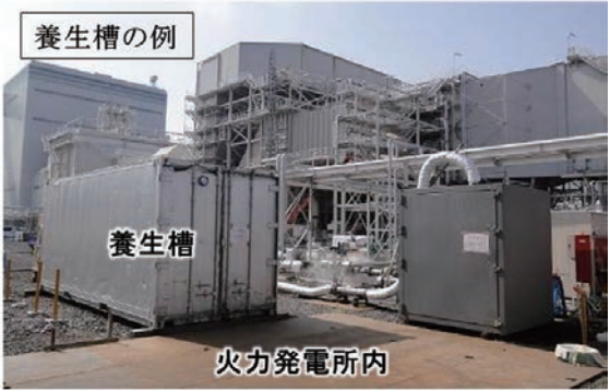
図6 火力発電所の排ガスによる炭酸化養生
