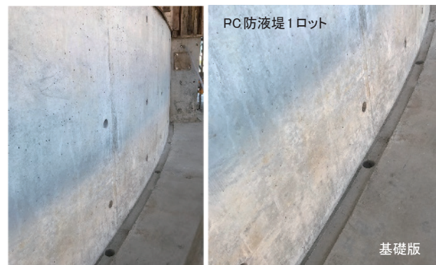
写真4 基礎版と1ロットの接合箇所の仕上がり
