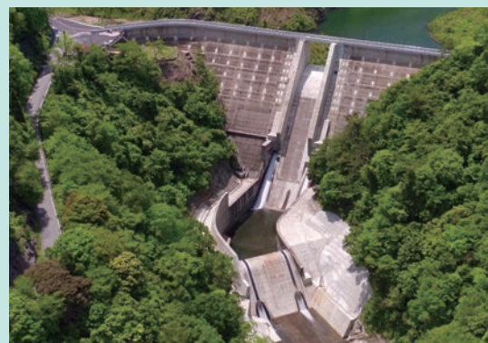
ダム再開発工事における洪水吐および減勢工コンクリートの改造 《浜田川総合開発事業浜田ダム再開発工事》
