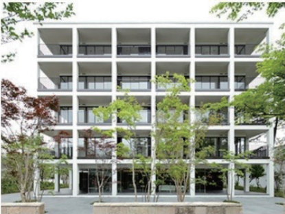
東京都 バルコニーの天井
