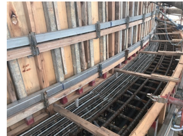
写真1 1ロットの型枠組立とラス金網設置状況
