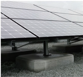
山口県 太陽光発電パネルの基礎
