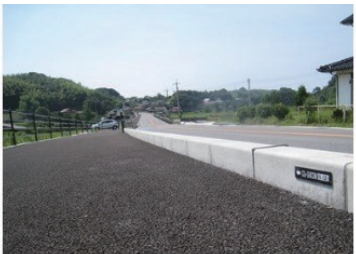
島根県 境界ブロック
