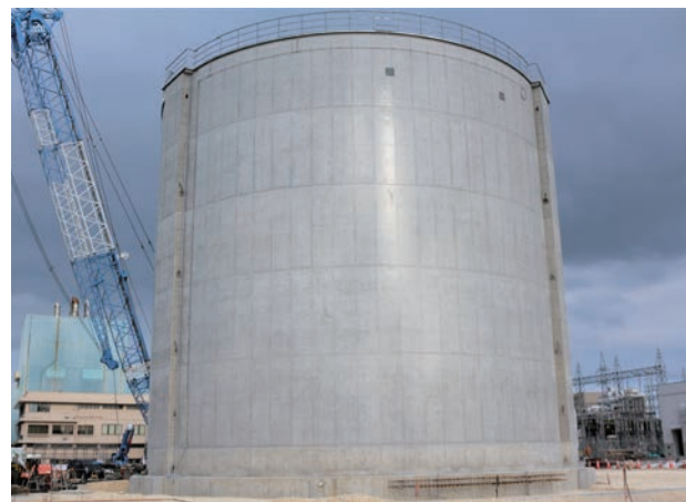
写真6 地上式LNGタンクの構築状況
