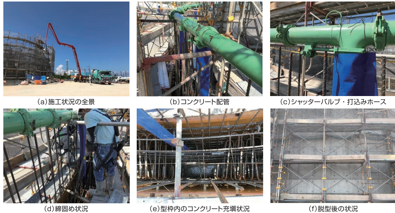
写真5 PC防液堤コンクリートの施工状況
