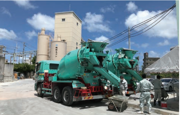
写真2 実機試験状況
