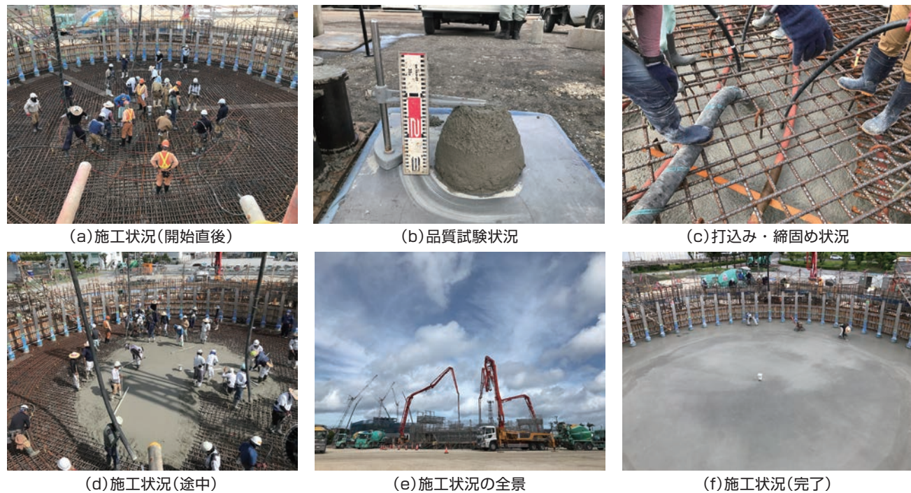
写真3 基礎版コンクリートの施工状況
