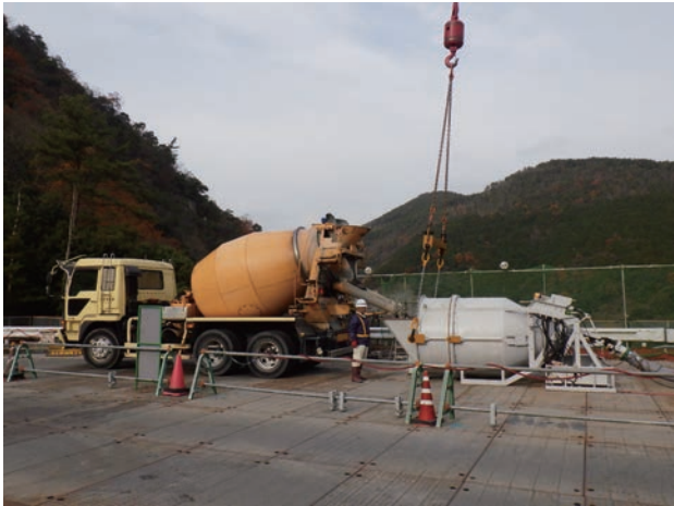
写真 10 コンクリート積替状況
