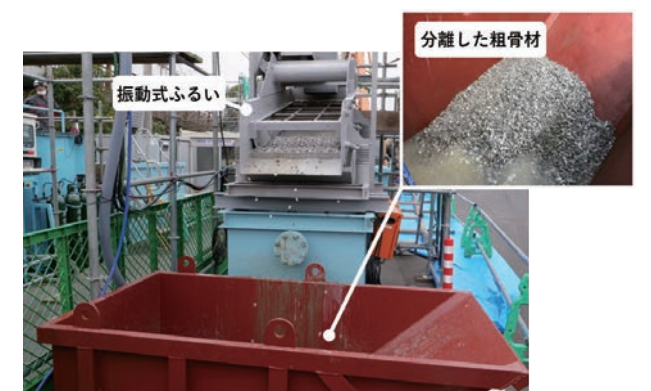
写真2 散水装置付き振動ふるいの稼働状況
