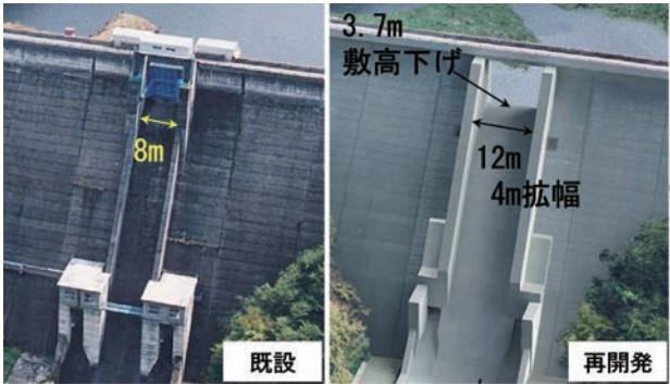
写真8 堤頂部改造概要
