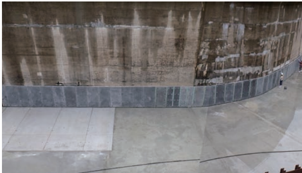
写真6 UFCパネル設置状況
