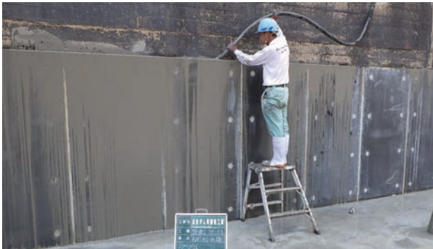
写真7 UFCパネル施工状況
