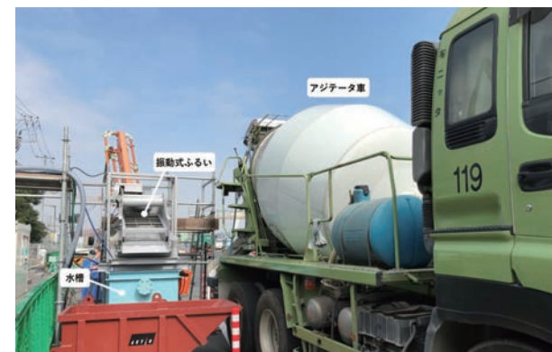
写真3 アジテータ車からコンクリートを散水装置付き振動ふるい投入到している状況
