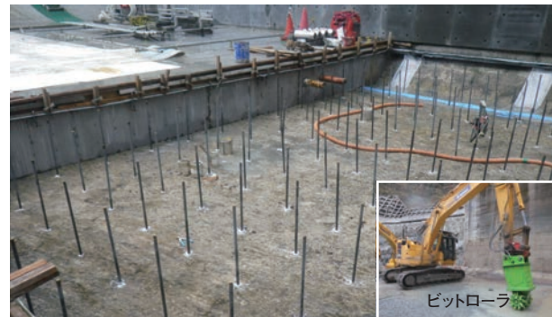
写真2 水叩き部打設前(差し筋・チップング)
