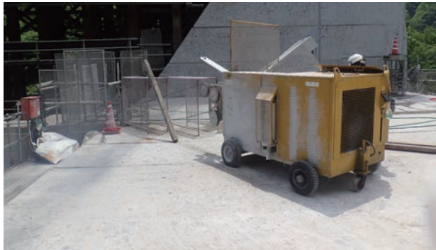
写真9 大型ワイヤーソー施工状況
