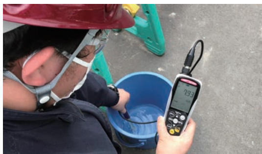
写真5 放流前の処理水のpHの確認
