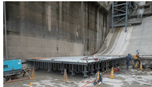
写真3 ライニング材据付状況
