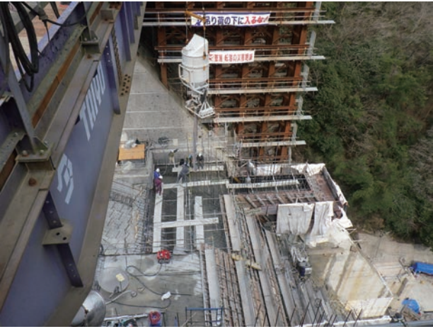
写真 11 堤頂部コンクリート施工状況
