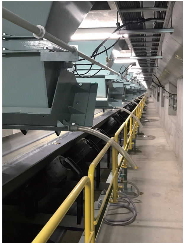
写真2 骨材ヤード下通路
