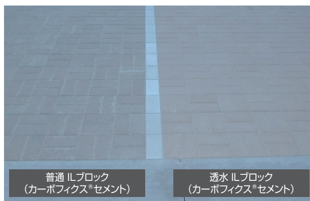
写真4 実機製造ILブロックの敷設状況
