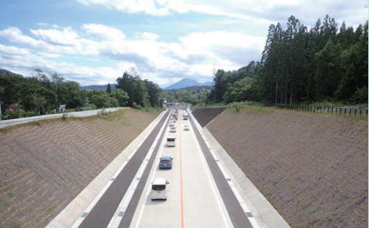
国道18号妙高大橋架替における連続鉄筋コンクリート舗装の施工
