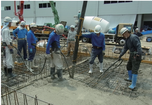
写真3 附属棟打設状況
