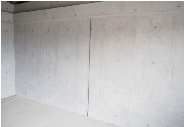
写真4 附属棟壁出来型
