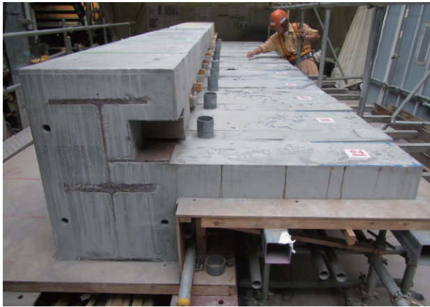
写真1 施工実験後の試験体の外観
