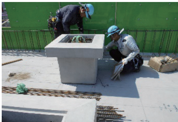
写真11 部材設置状況
