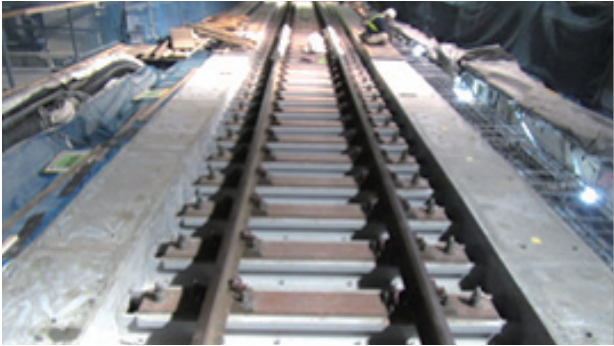
写真3 施工完了後の外観
