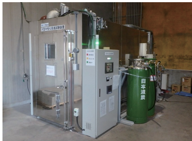
写真3 大型炭酸化養生装置(実機設備)
