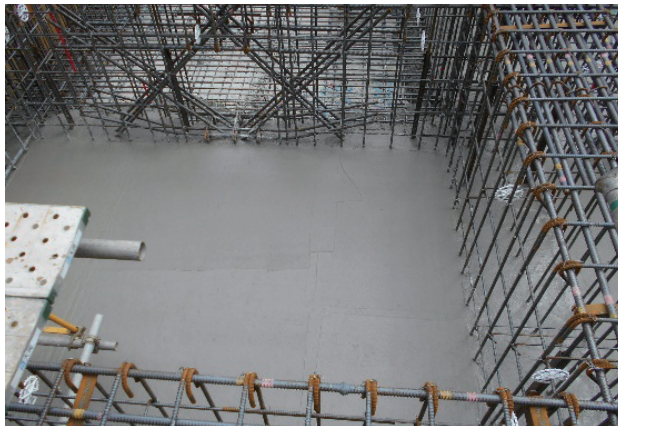
写真8 耐圧版打設後
