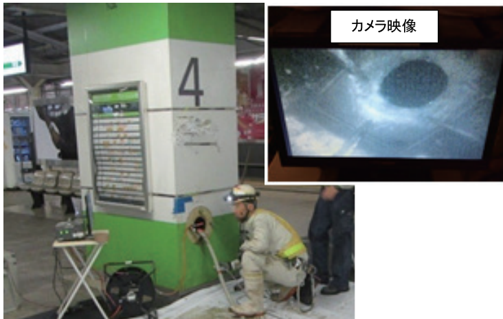
写真5 充填材打設状況
