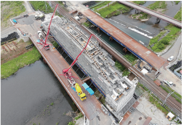
写真9 アーチ打込み状況
