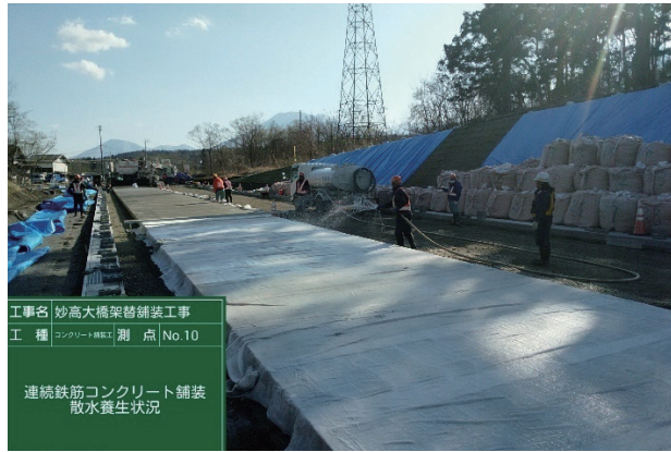
写真8 養生マット設置
