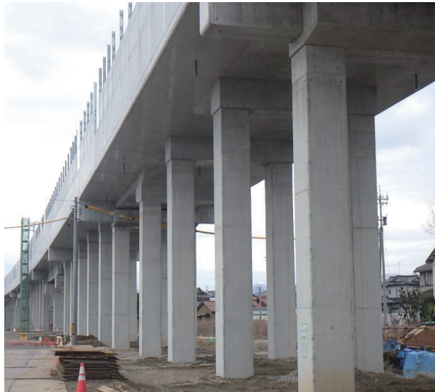
写真6 新幹線橋梁の適用事例
