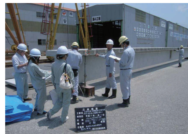
写真5 PC桁の製造状況
