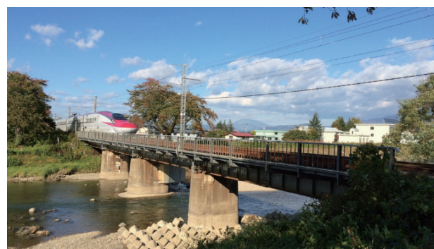
写真2 架け替え前の斉内川橋りょう
