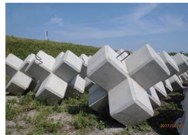
写真4 護岸ブロック施工状況(脱枠後)
