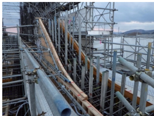
写真5 単管パイプ設置状況
