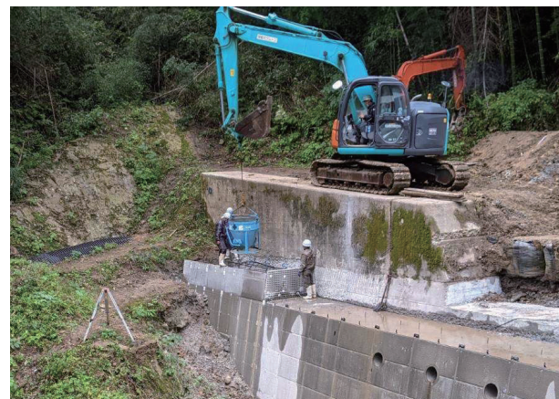
写真1 堰堤の打設状況
