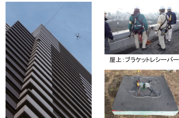
写真1 係留式ドローンによる外壁調査概要
