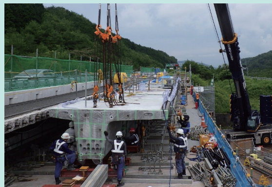
高炉スラグ細骨材を適用した新名神高速道路・つめた谷橋(下り線)の拡幅工事
