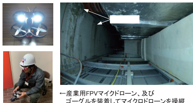
写真5 産業用マイクロドローンで撮影した漏水痕
