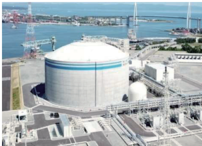
写真8 LNGタンクの全景
