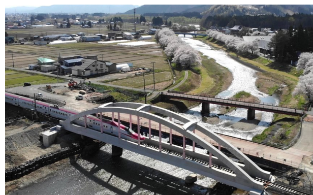
写真1 完成後の写真(2021年4月)
