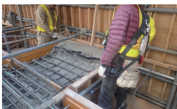
写真4 横桁への吹き出し状況確認
