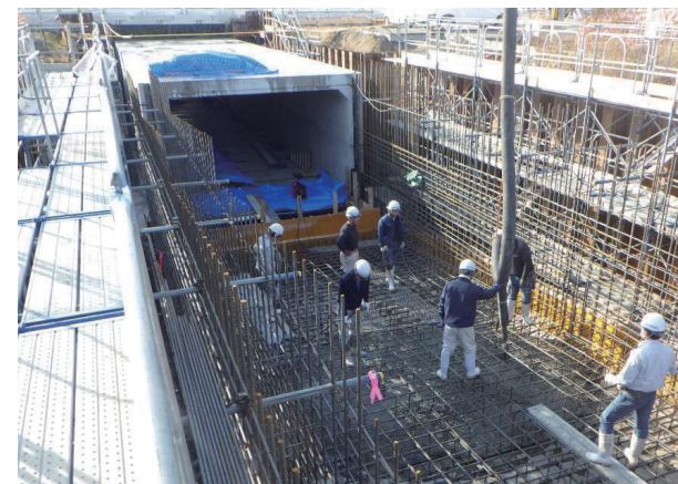
写真2 函渠の底板打設状況
