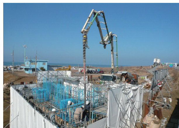
写真3 橋台の打設状況
