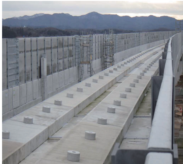
写真7 新幹線スラブ基盤の適用事例
