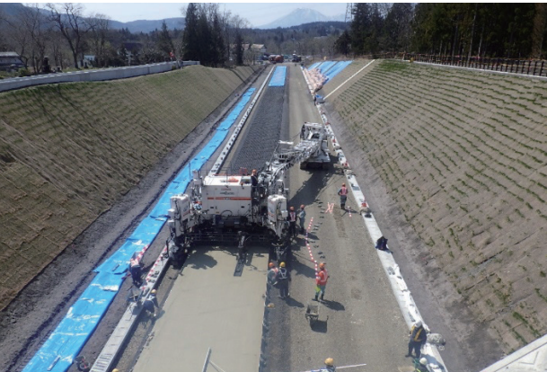
写真5 打設状況（新潟県側より望む）
