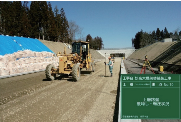
写真2 路盤整正・転圧（マシンコントロール）
