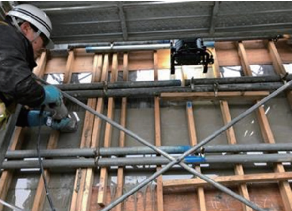
写真7 透明型枠と型枠バイブレータの使用状況
