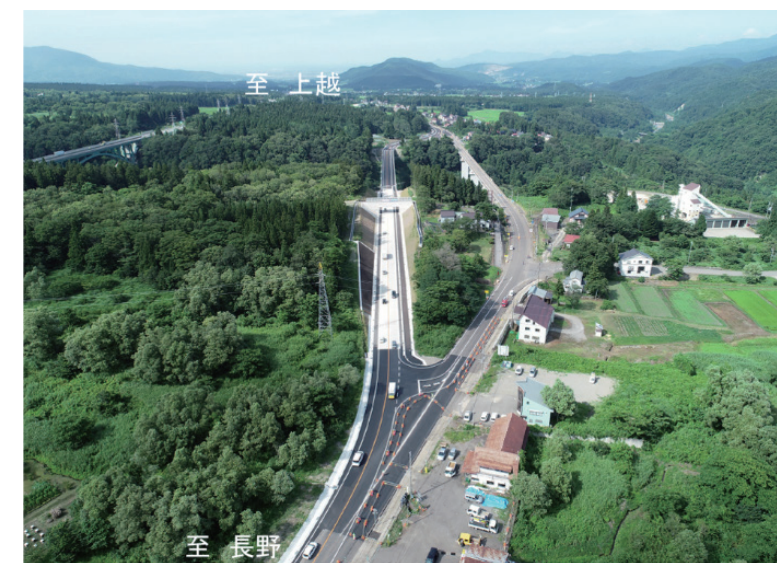
写真1 連続鉄筋コンクリート舗装施工箇所
