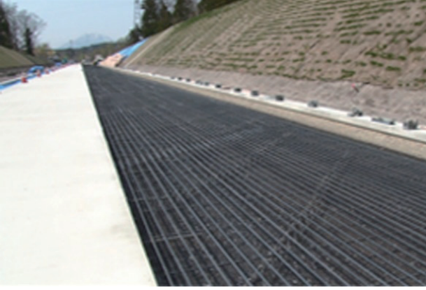
写真3 鉄筋組立
