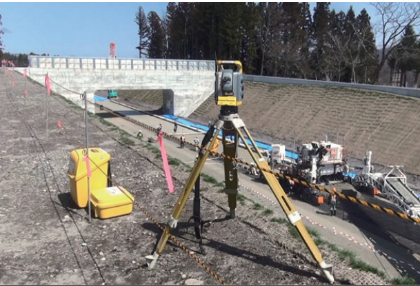
写真6 打設状況（マシンコントロール）
