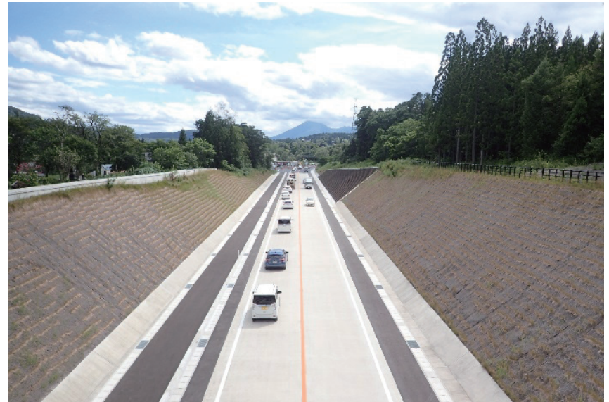
写真10 開通後の連続鉄筋コンクリート
