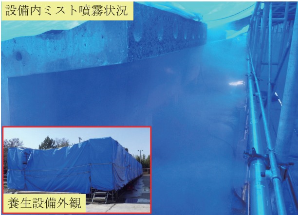
写真4 セグメントのミスト養生
