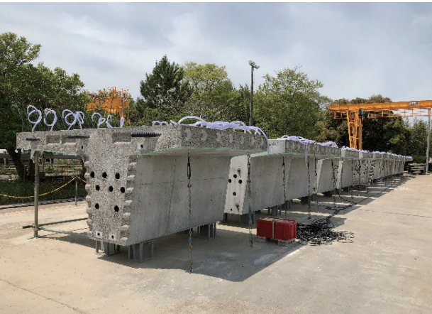
写真5 セグメント完成
