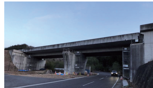
写真1 拡幅前の暫定供用
