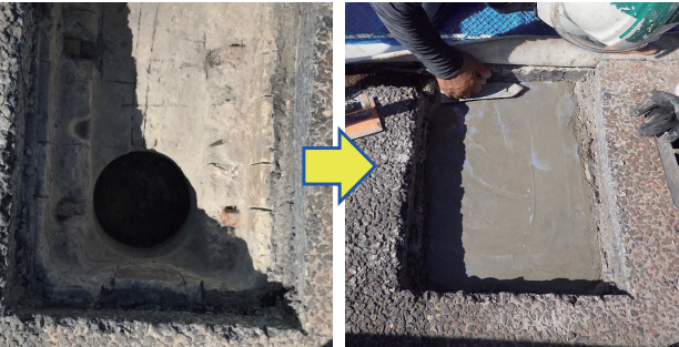
写真7 撤去した排水桝のあと埋め
