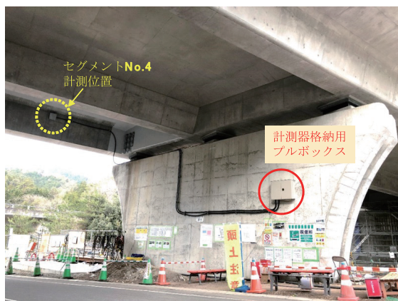
写真9 実橋における計測状況
