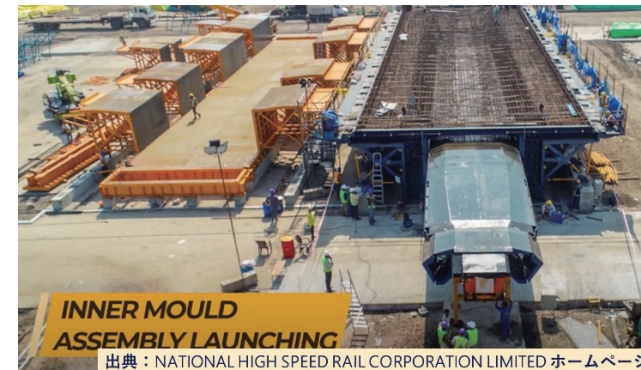
写真3 内型枠設置状況
