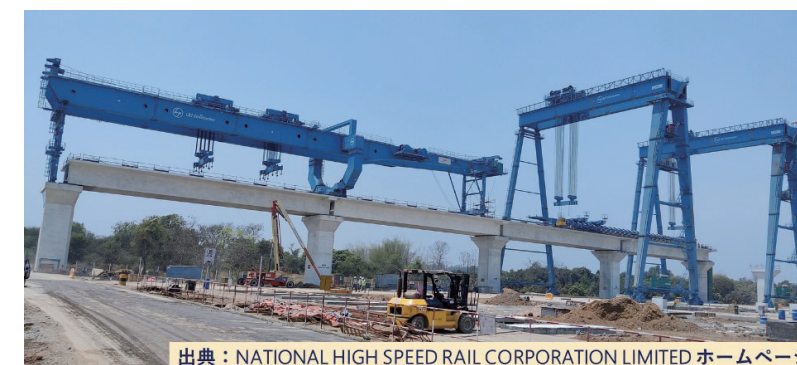
写真4 FSLMに用いられる架設設備
