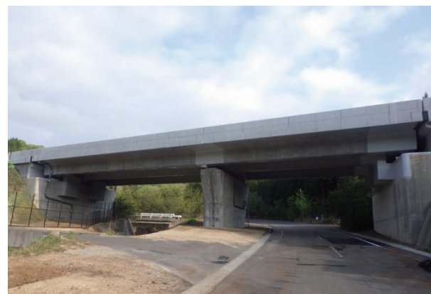
写真10 工事完了全景
