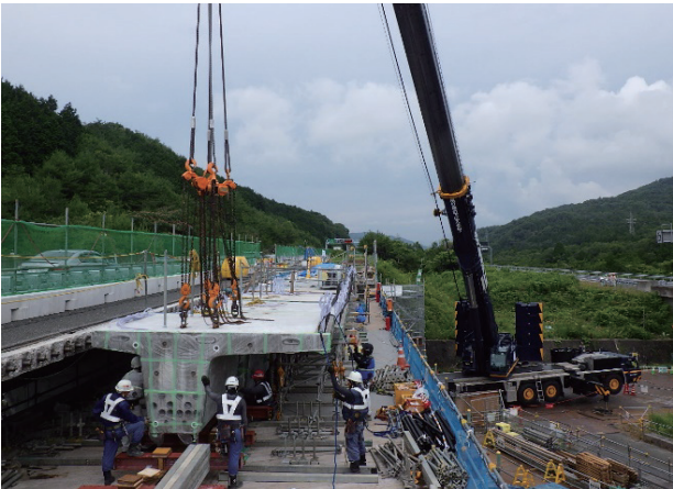
写真6 セグメント架設
