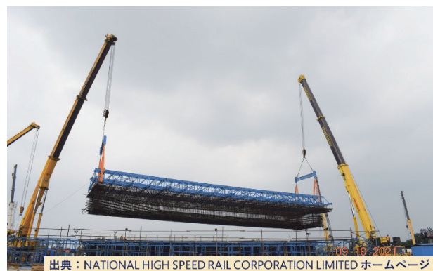
写真2 箱桁鉄筋籠吊り上げ状況
