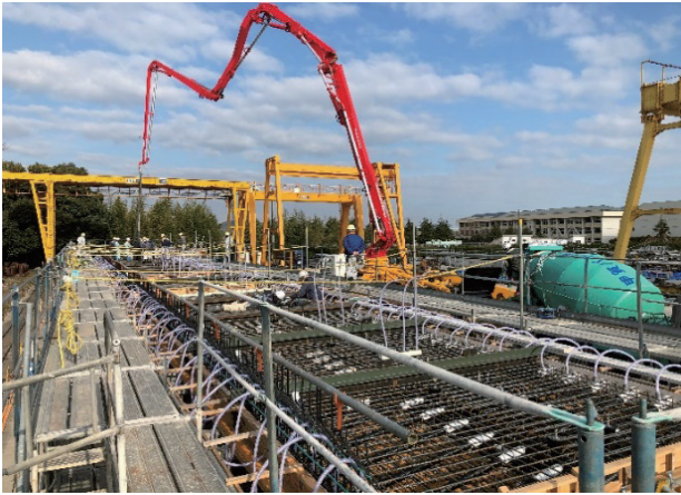
写真3 BFSコンクリート初の現場打ち
