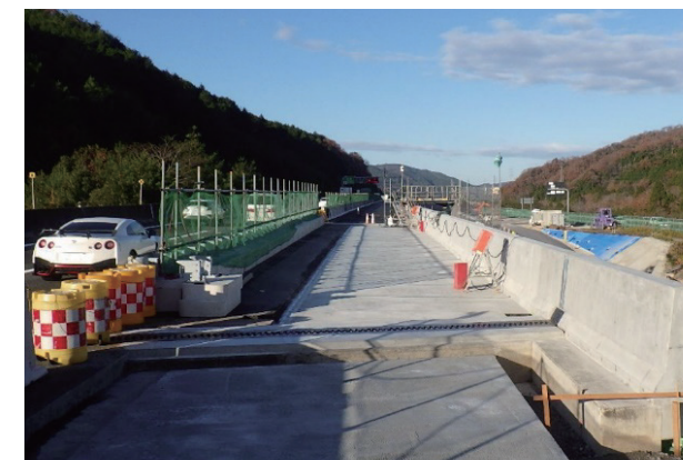
写真11 橋面(舗装前にA1側より)
