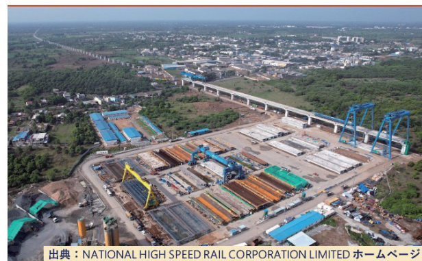
写真1 桁製作ヤード(FSLM発進基地)
