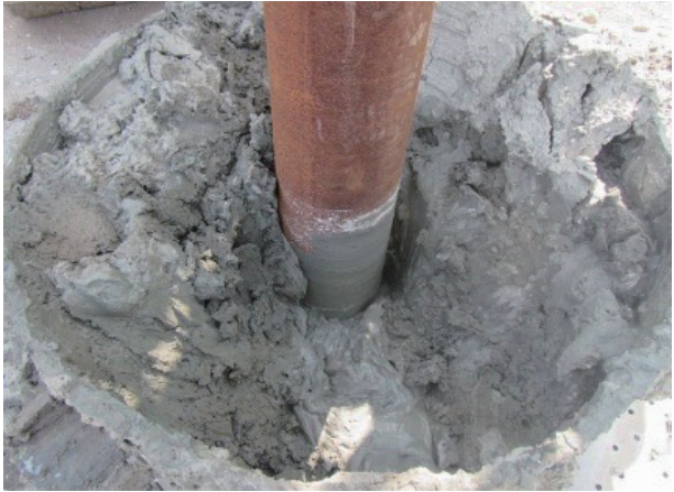
写真2 造成中の掘削・攪拌ロッド周辺の状況 [GL-29m 付近掘削時]
