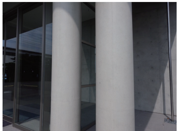
写真9 施工後2年経過時の表層状況
