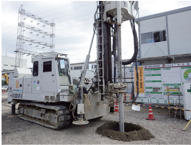
写真3 ECMソイル施工状況
