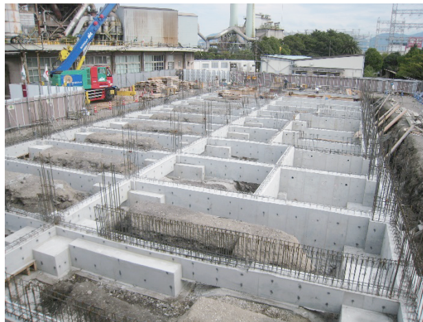
写真6 基礎および地中梁
