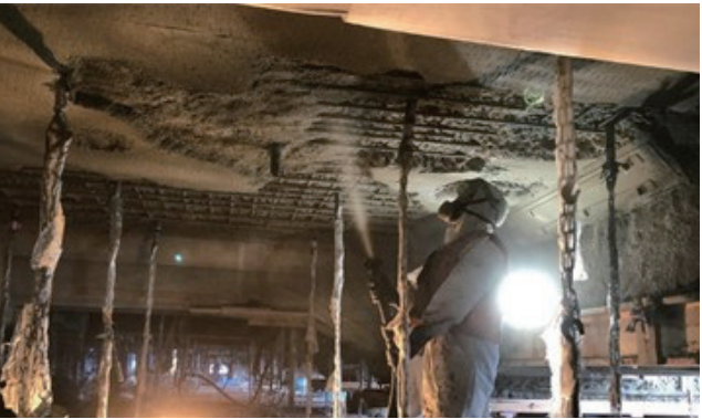
写真7 栈橋補修状況 [左：吹付補修状況，右：仕上後の状況]
