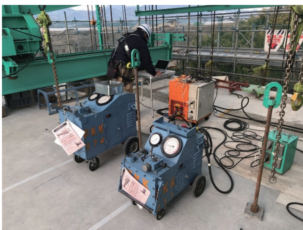
写真2 自動緊張施工状況
