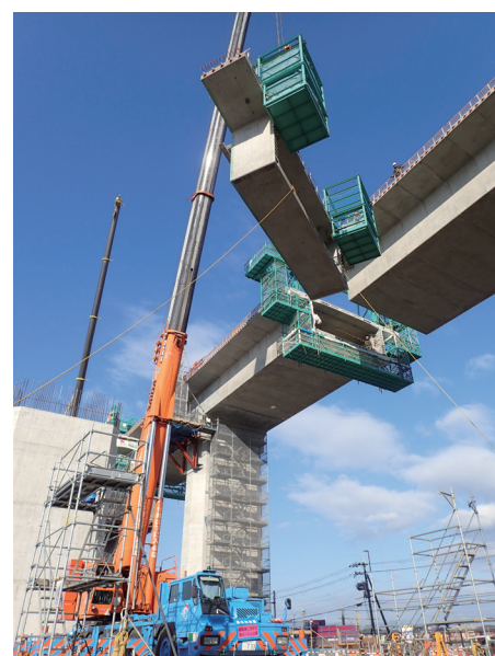
写真1 クレーンによるセグメント張出架設
