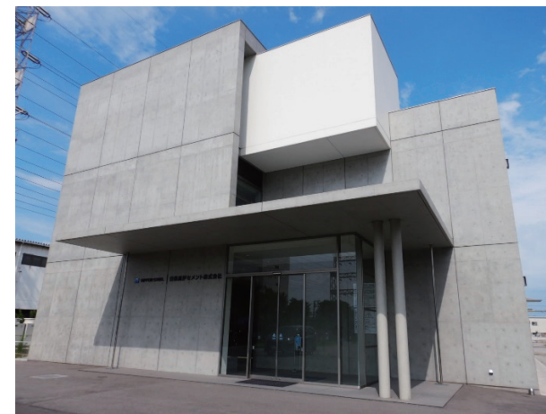
写真1 日鉄高炉セメント(株)本社事務所
