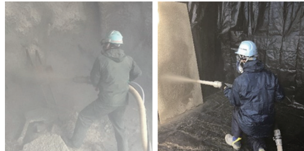
写真3 粉塵発生状況の比較 [左：対策を実施していない乾式吹付工，右：本工法]
