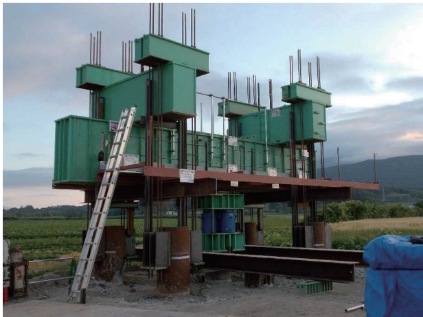
写真1 荷重試験状況
