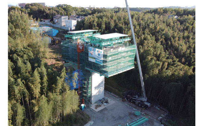
写真1 クレーン配置状況
