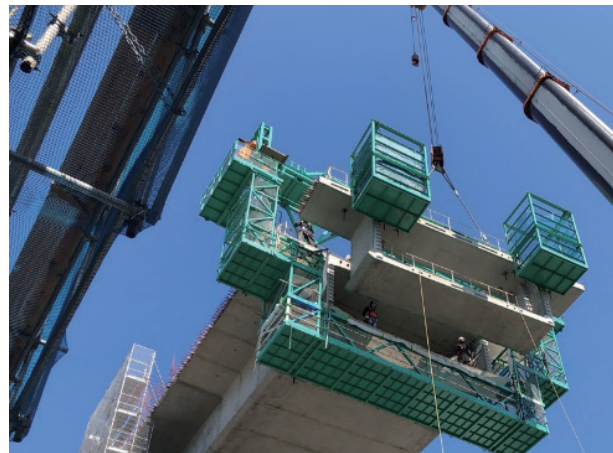
写真6 鋼製足場ユニット
