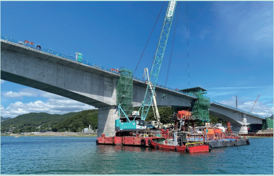
一般国道42号新宮紀宝道路・熊野川河口大橋(仮称)のコンクリート施工
