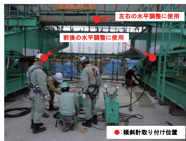
写真6 自動据え付け施工状況
