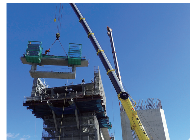
写真2 基準セグメントの架設
