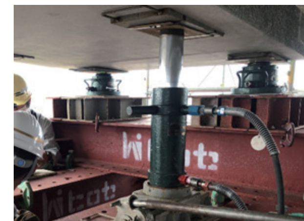
写真3 調整架台とロックナット付き油圧ジャッキ
