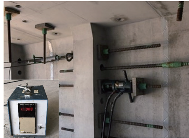
写真5 引寄せ鋼棒の緊張力計測
