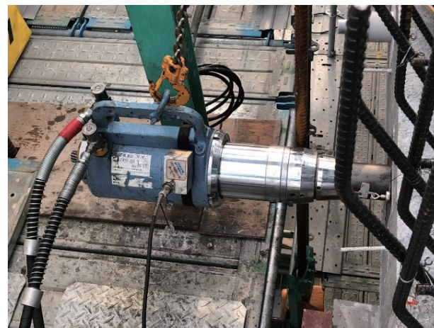
写真3 緊張ジャッキ設置状況
