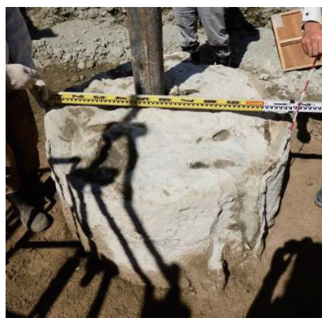
写真3 杭頭部掘り起こし状況
