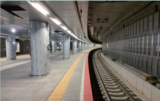
うめきた(大阪)地下駅におけるコンクリート品質向上の取り組み
