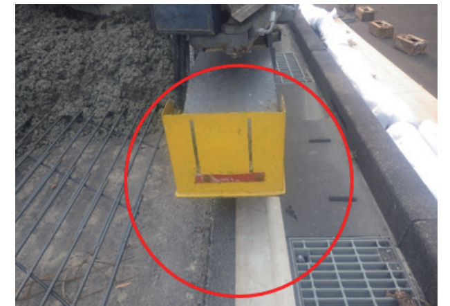
写真4 スリップフォーム足場位置
