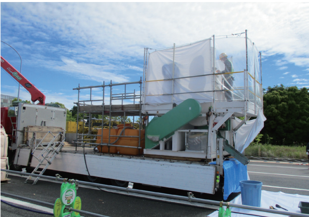
写真2 車上プラント配置状況
