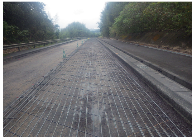
写真2 鉄筋配置状況
