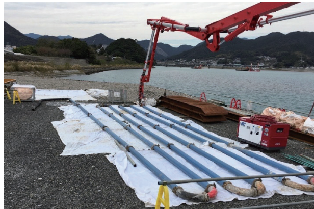
写真2 圧送試験状況
