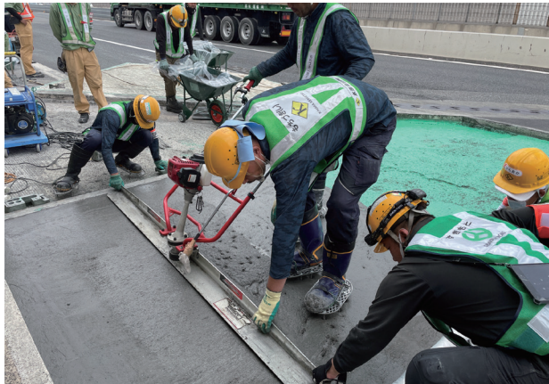
写真3 大型エンジンスクリード使用
