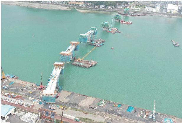
写真1 船舶使用状況
