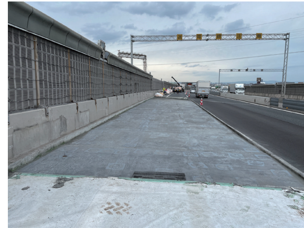
写真4 施工完了全景
