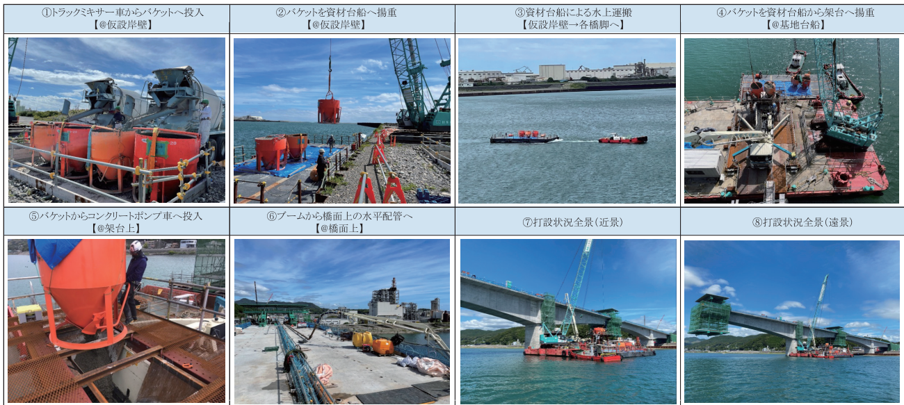
写真3 水上打設のステップ
