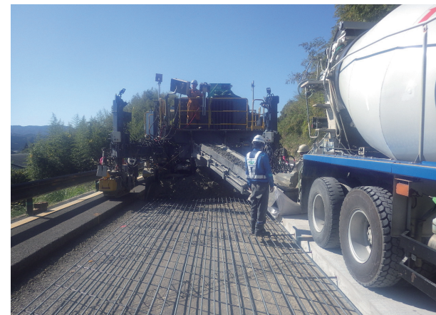
写真3 コンクリート打設状況
