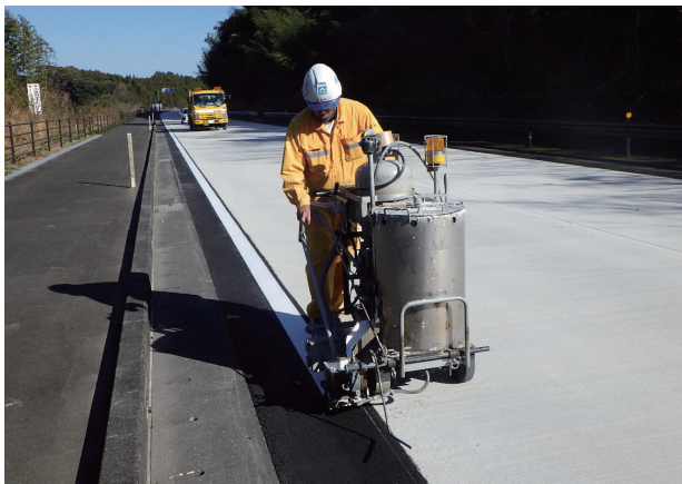
写真5 外側線塗布状況
