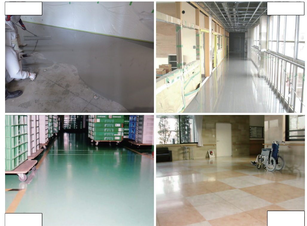
図4 エスレベルの施工例
