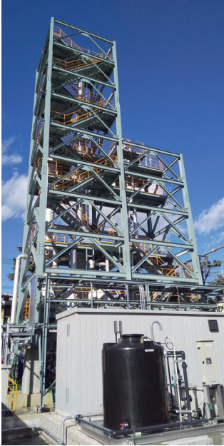
写真2 熊谷工場に設置した実証試験プラント 〔日量10t-CO 2 回収〕
