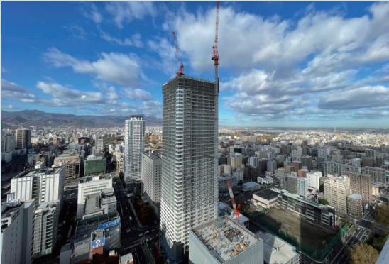
北海道内最高高さの超高層RC建物の設計と施工 ーONE札幌ステーションタワーー
