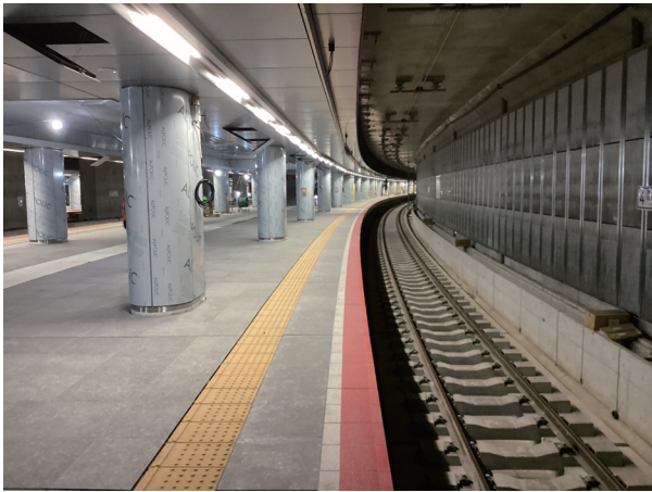
写真5 現在の施工状況(ホーム階)
