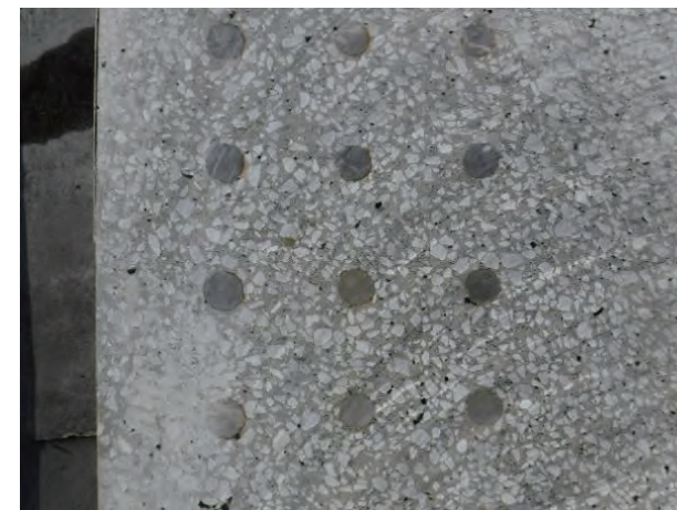
写真2 鉄筋周辺の状況
