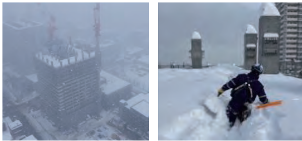
写真6 冬季の施工状況
