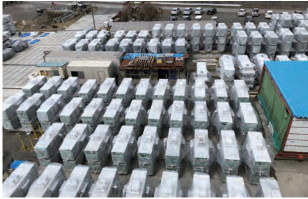
写真4 PCa柱部材の貯蔵状況
