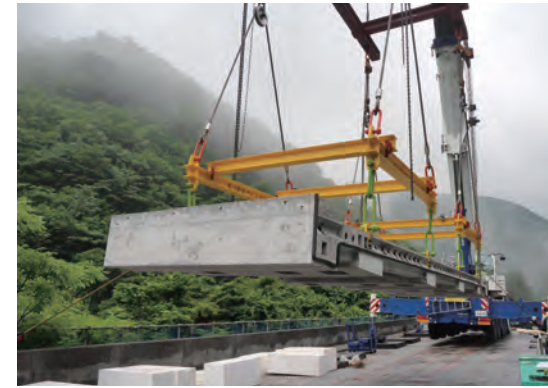
写真6 Dura-Slab吊り上げ
