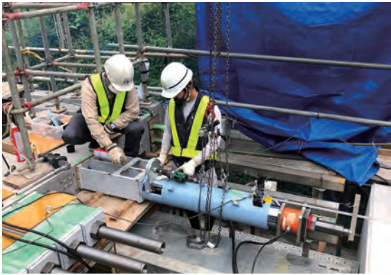
写真7 AFRPロッド緊張(縦締め)
