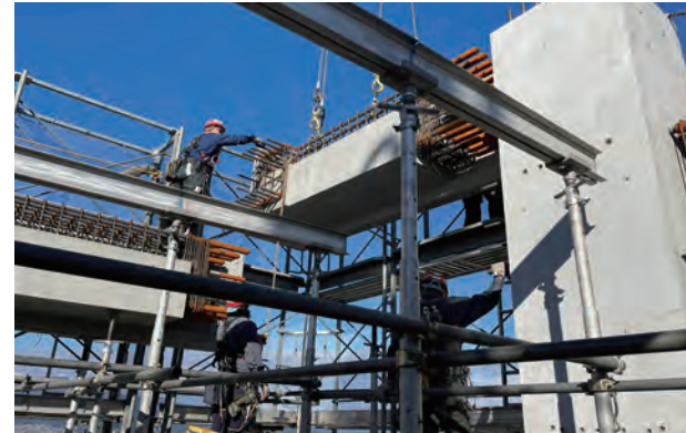
写真5 PCa柱、梁の設置状況
