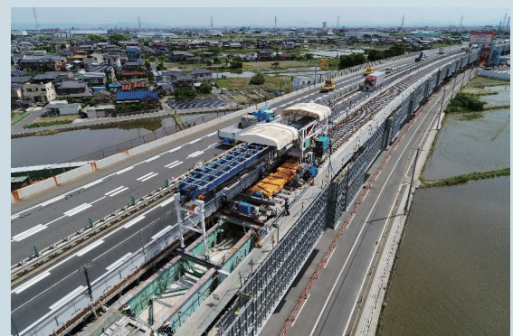
東名阪自動車道 弥富高架橋(下り線)における床版取替工事
