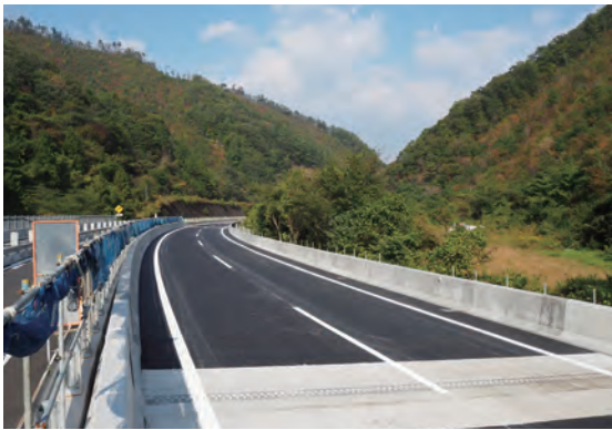
写真8 蓼野第二橋(下り線)完成
