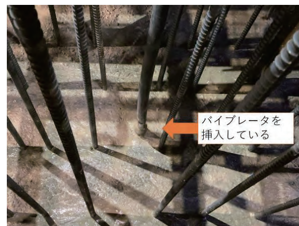
写真5 18時間経過後の超遅延コンクリート [パイプレータの挿入が可能]
