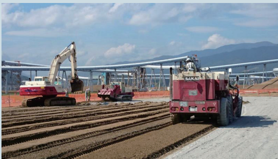
シリーズセメント系固材材 その特性と広がる可能性③セメント改良技術の適用事例・浅層混合処理
