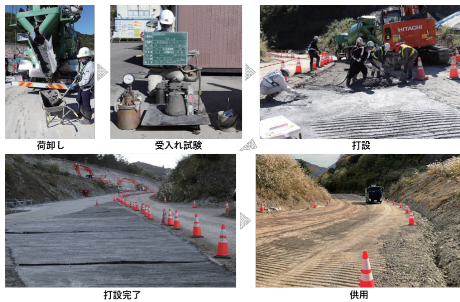
図8 場内工事用道路の仮舗装コンクリートへの適用
