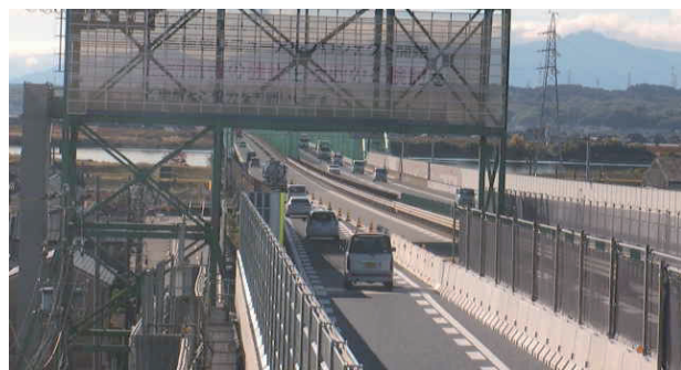
写真12 床版取替後の走行車線を通行している様子
