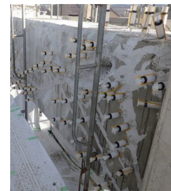
写真5 中層梁 復旧状況
