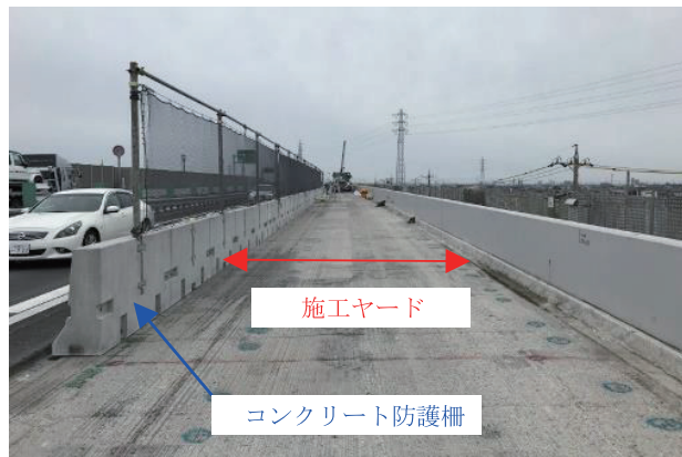
写真11 コンクリート防護柵(SB種)の設置状況
