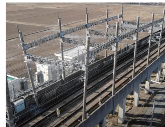
写真9 特殊箇所の全景
