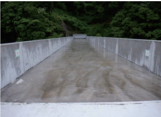
普通コンクリート
