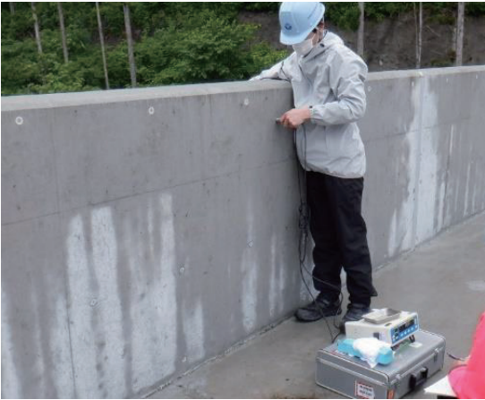
写真6 壁高欄における超音波伝播速度の測定状況
