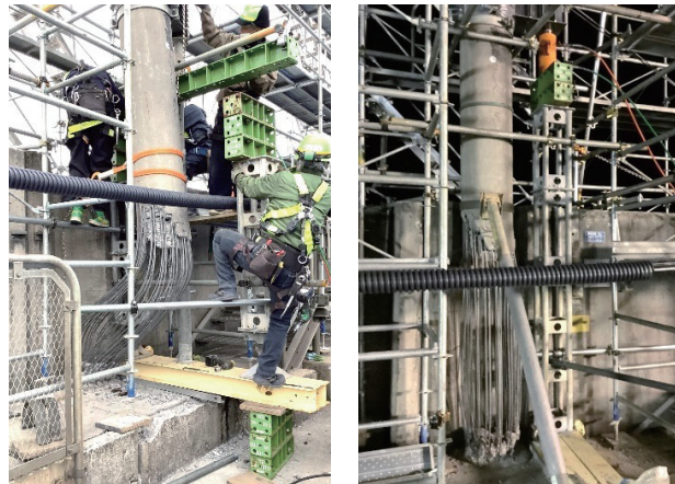
写真10 電柱基部のジャッキアップ施工
