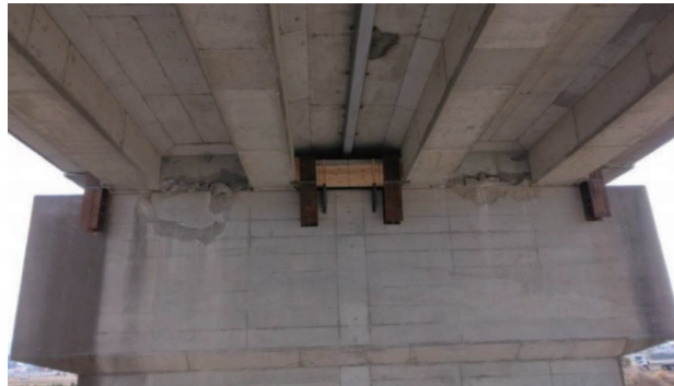
写真7 応急対策実施後の状況
