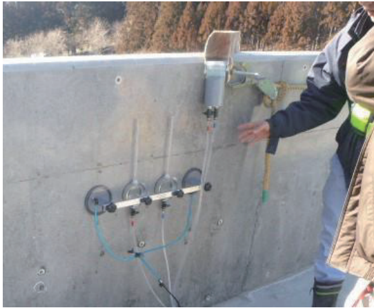
写真7 壁高欄における表面吸水試験
