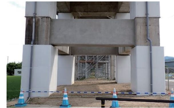
写真3 鋼板巻き立て完了状況
