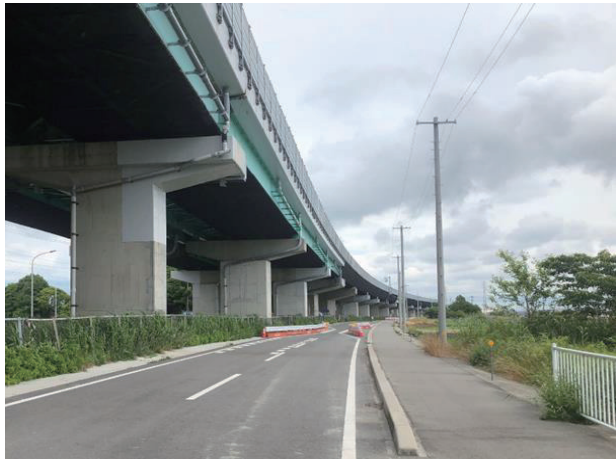
写真4 工事着手前の側道状況
