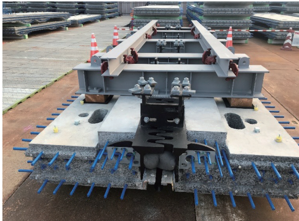
写真9 床版と伸縮装置との一体化
