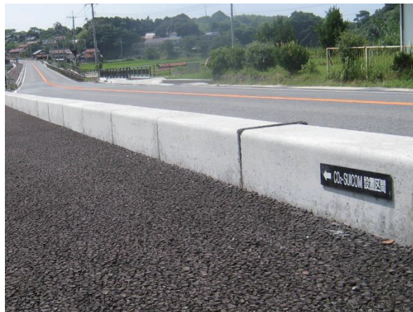
図8 カーボンネガティブコンクリート CO 2 -SUICOM 17)
