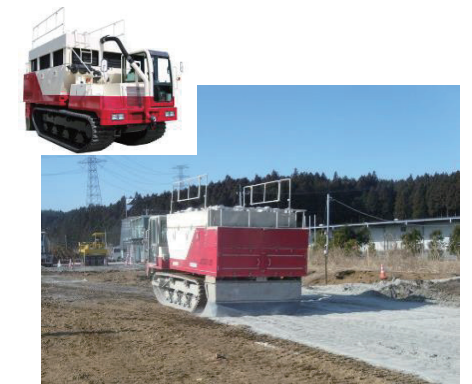
写真7 固化材散布車
