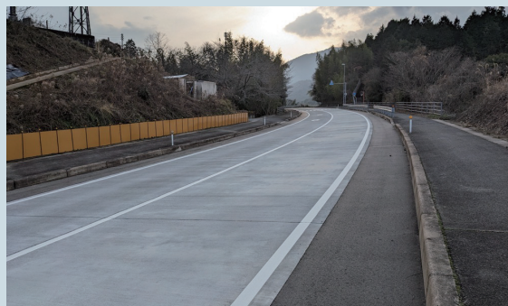
国道185号呉市安浦町地内におけるコンクリート舗装修繕工事
