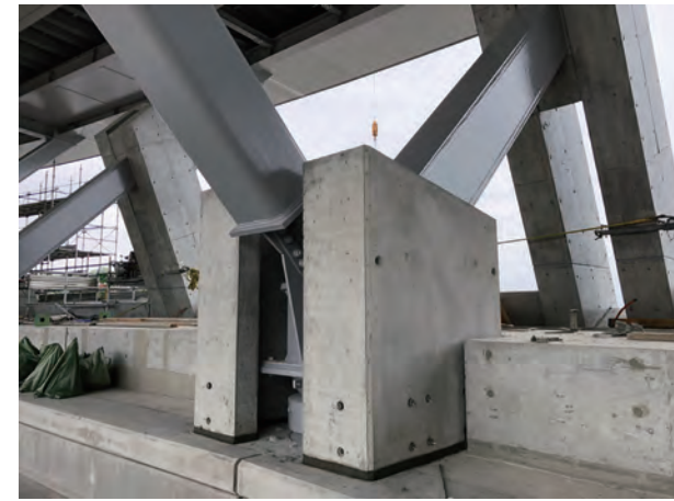
写真17 取付後(鉄骨柱との取り付け部)
