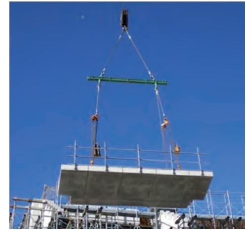
写真10 床付き小梁架設状況
