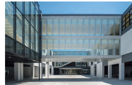
写真6 PRCスラブの渡り廊下
