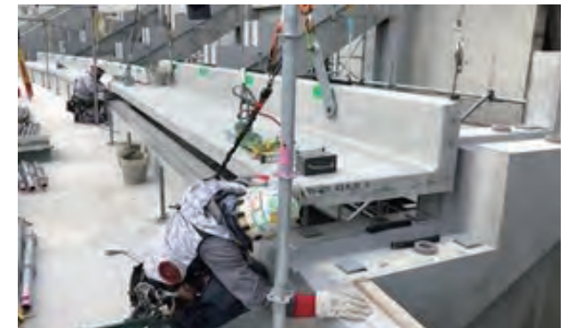
写真12 段床版据付け状況
