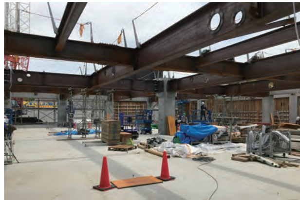
写真8 PC-S梁架設状況
