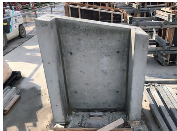
写真16 柱脚部囲い壁
