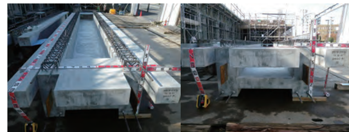
写真4 床下配管スペースつきDT版
