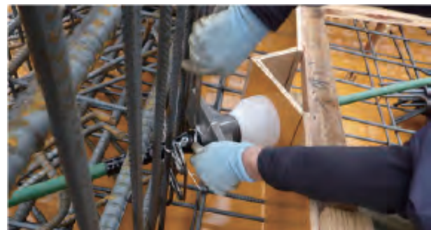
写真7 ジャッキスペースの確保
