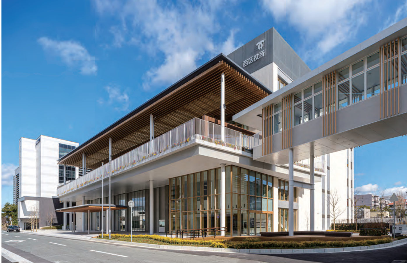
写真1 建物全景 [撮影：松村芳治]
