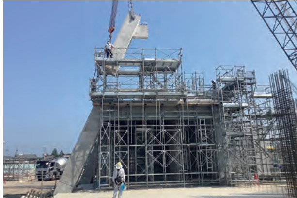
写真3 メインスタンド斜め柱施工状況
