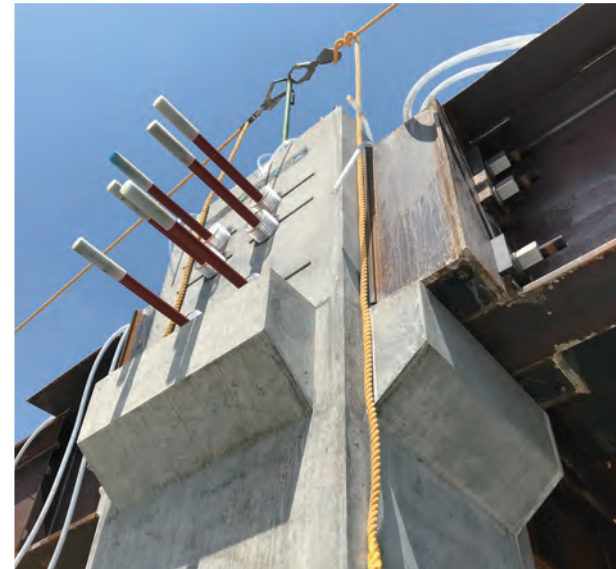
写真9 柱梁接合部の状況
