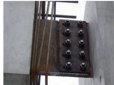
写真13 ガセットプレート接合
