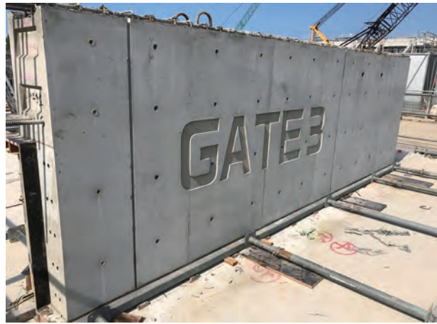
写真13 サイン文字入り垂れ壁付き小梁
