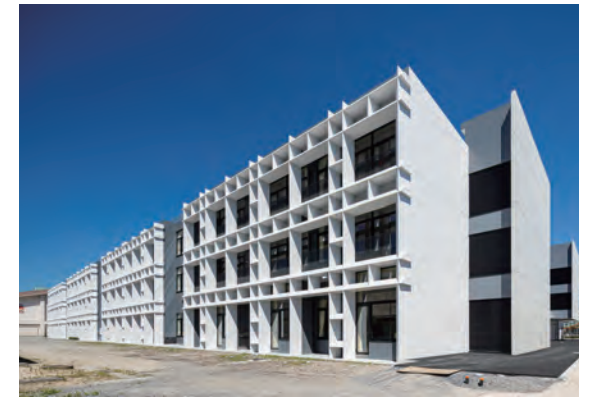
写真14 校舎南面外観
