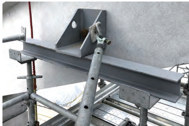
写真7 段梁側面鋼製ブラケット
