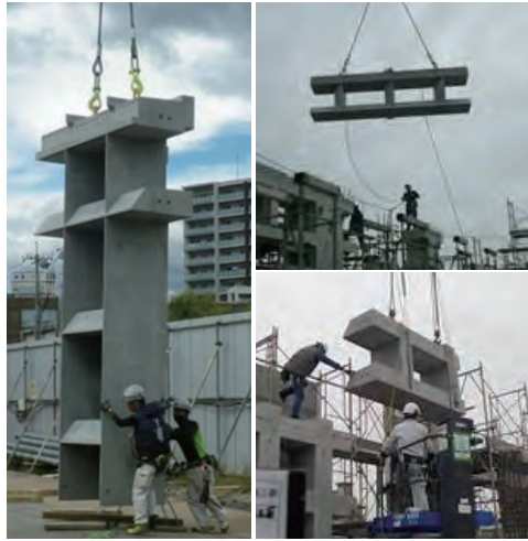
写真11 フィーレンディール架構の架設状況
