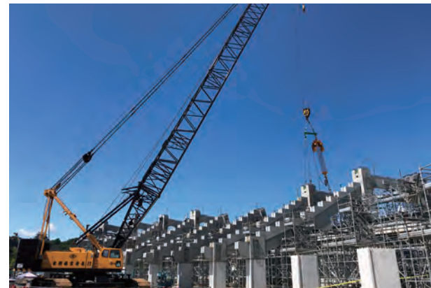
写真8 段梁架設状況
