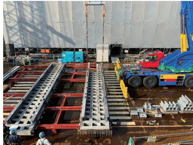
写真6 格子壁 建て方2
