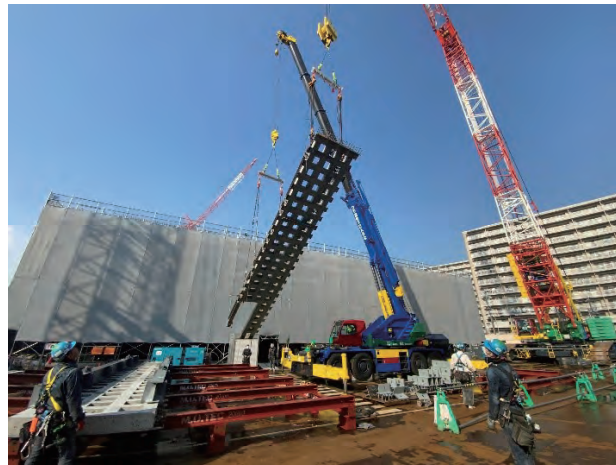
写真5 格子壁 建て方1
