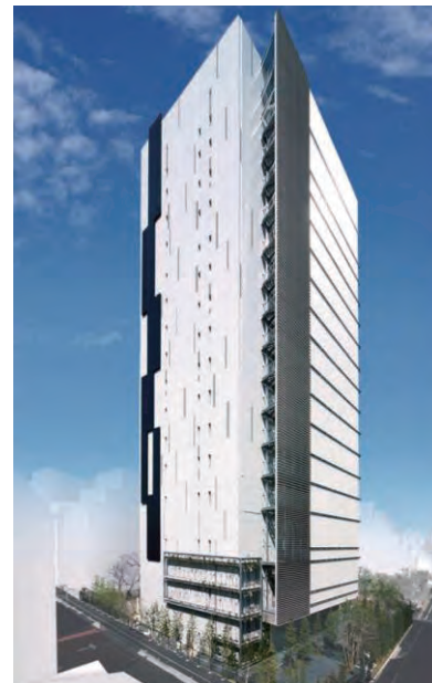
写真1 東京第5データセンター 1)
