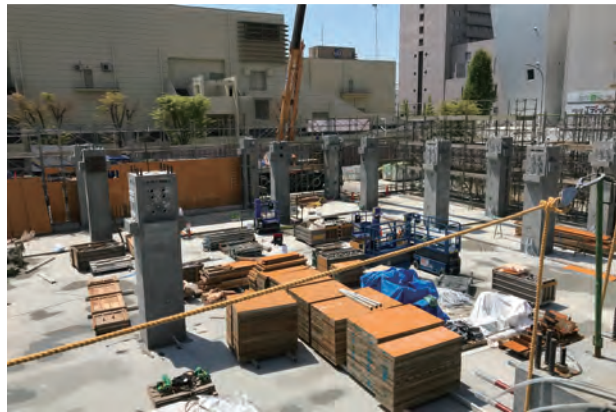
写真7 PC柱架設状況
