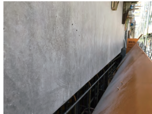
写真10 RC壁の型枠
