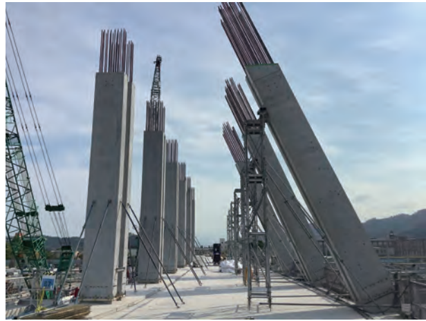
写真5 バックスタンド斜め柱施工状況
