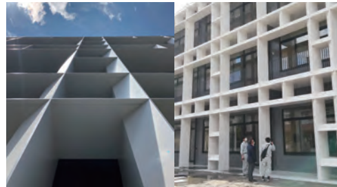
写真12 建て方後のフィーレンディール架構
