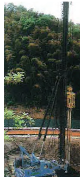
写真1 CDM工法施工機械 1)
