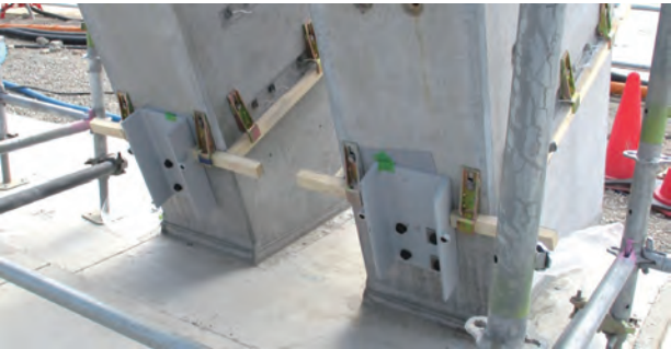
写真4 斜め柱柱脚部施工状況
