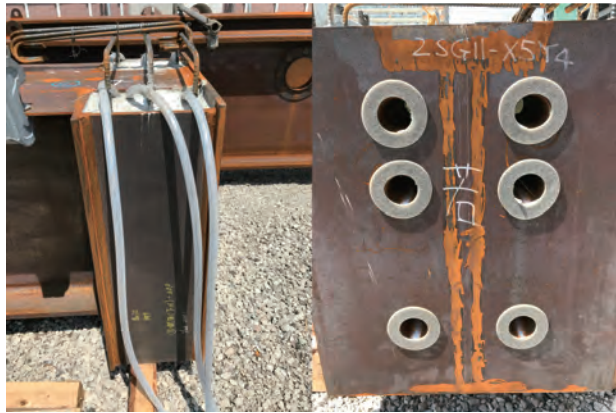
写真5 PC-S梁端部
