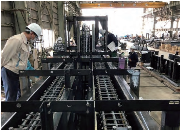
写真2 斜め柱製作状況
