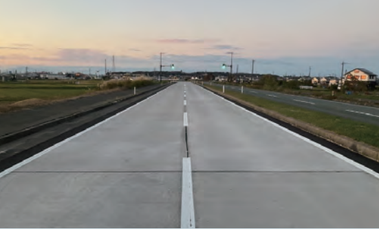
主要地方道秋田北インター線コンクリート舗装による現道補修- アスファルト舗装からコンクリート舗装へ
