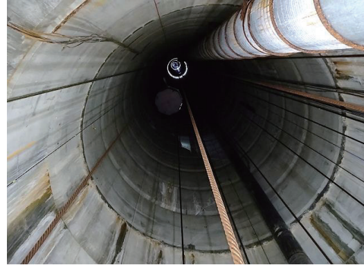
写真2 立坑内部の外観(底版からの見上げ状況)
