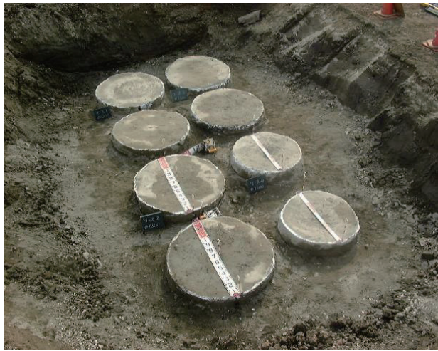
写真1 杭頭確認状況(左 φ1,300mm 右 φ1,000mm)
