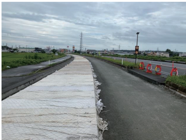
写真6 養生マット設置
