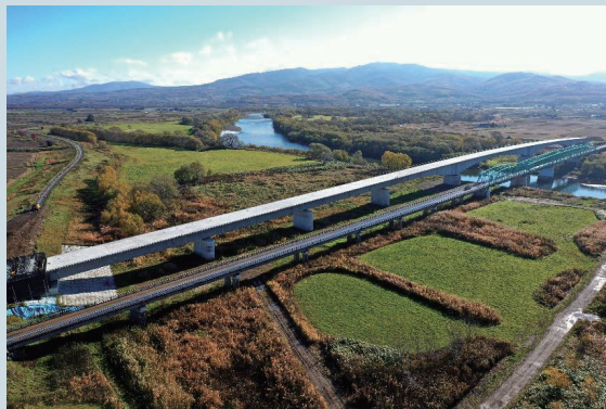
押出し仮設工法で石狩川を渡河する妹背牛橋の施工
