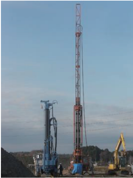
写真3 単軸施工機全景(左:汎用機 右:従来機)
