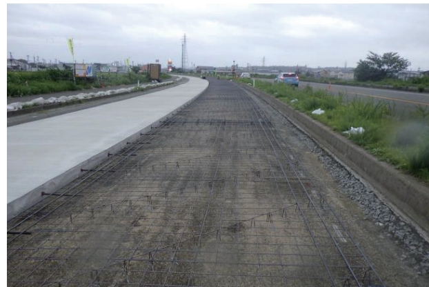
写真2 打設前の作業幅
