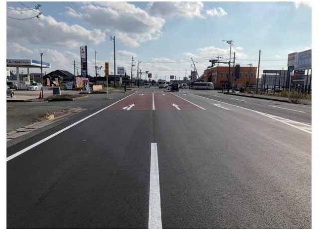
写真9 終点部のアスファルト舗装
