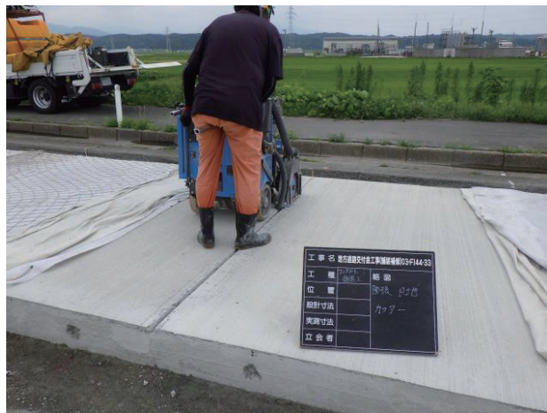
写真7 カッター目地設置
