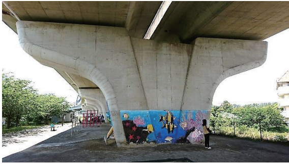
写真1 高架橋橋脚の外観
