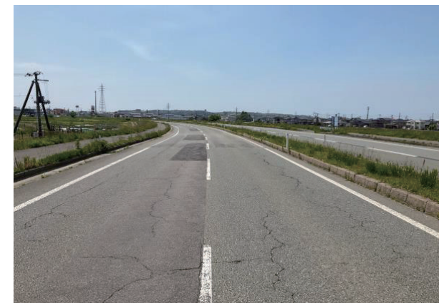
写真1 施工前の状況
