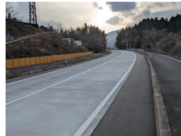
写真6 3年経過した施工箇所の現状 [広島市方面を望む]
