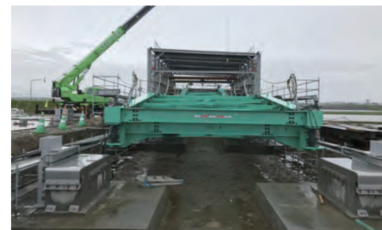
写真3 仮支柱部組立状況
