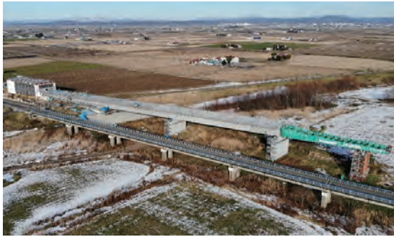
写真9 押出し施工全景
