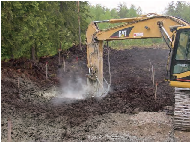
写真2 フィンランドでのMass Stabilization工法
