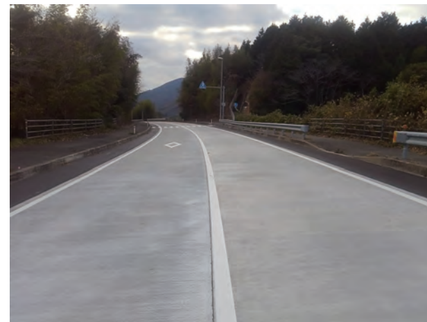
写真5 施工直後の状況 [広島市方面を望む]
