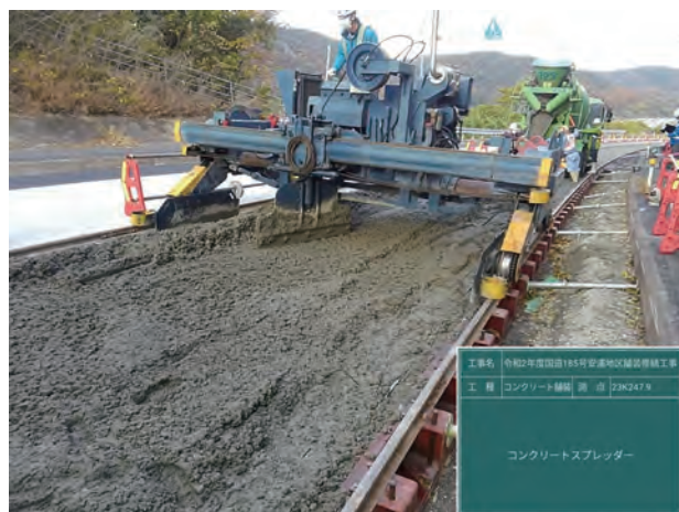
写真3 コンクリートスプレッダー
