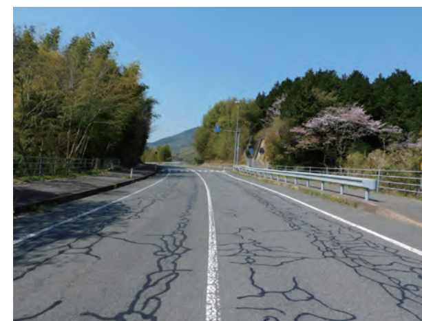
写真2 施工前状況(広島市方面を望む)
