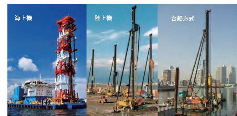
写真2 CDM機(海上・陸上・台船方式)
