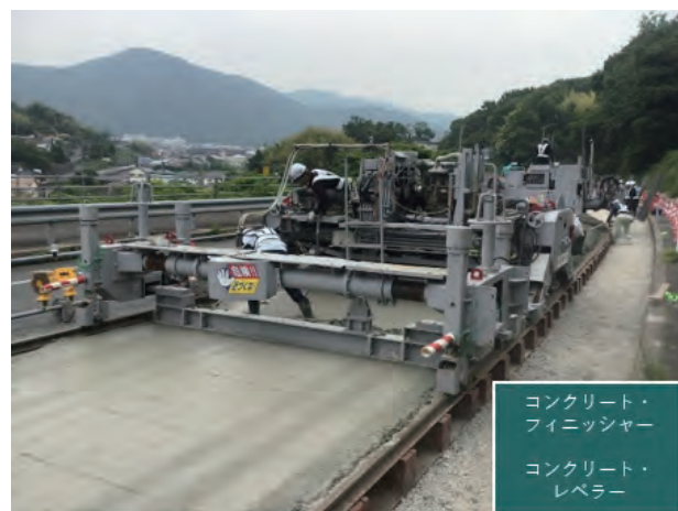
写真4 コンクリートフィニッシャー、レベラー
