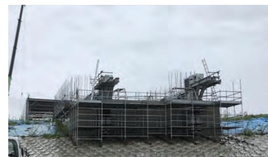
写真5 A1橋台押しブラケット設置
