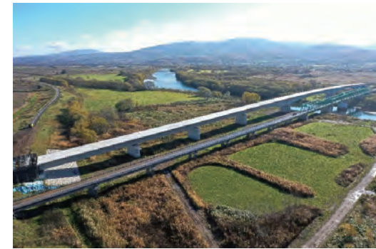
写真12 妹背牛橋 主桁連結完了
