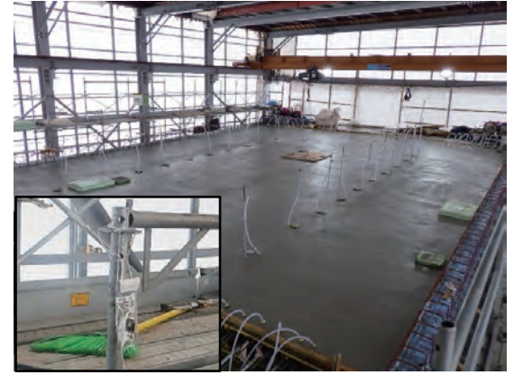
写真11 寒中コンクリート打設、温度測定
