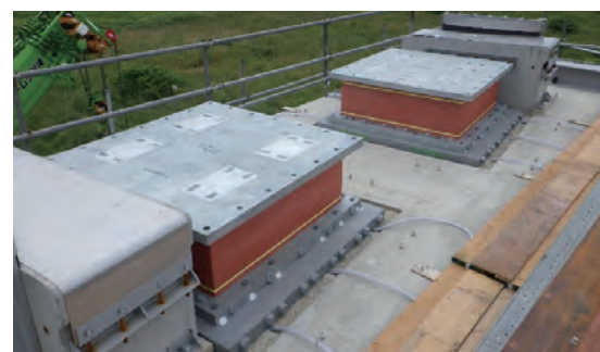
写真4 滑り支承設置・ゴム支承仮置き
