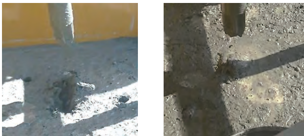
写真1 パイプレータの挿入跡
