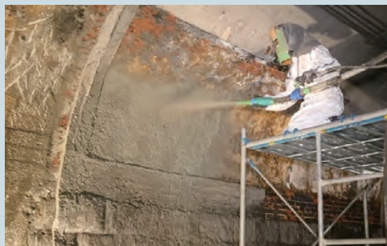
「リフレドライショット工法」の小断面補修工事への適応事例
