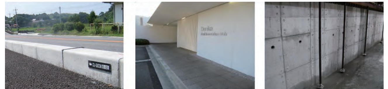
(a) 地先境界ブロック (b) インターロッキングブロック (c) 埋設型枠
