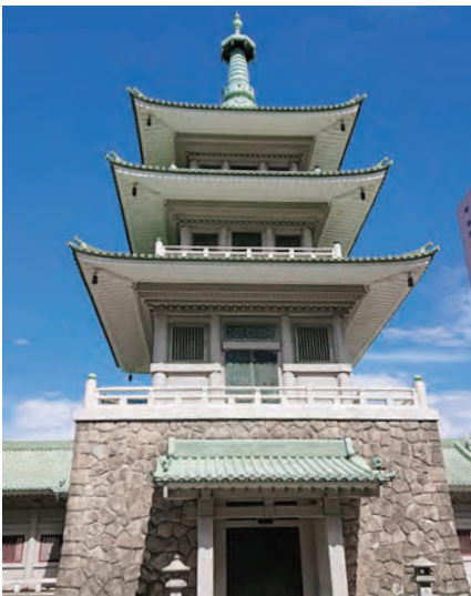
▲三重塔の基部は納骨堂になっている。
