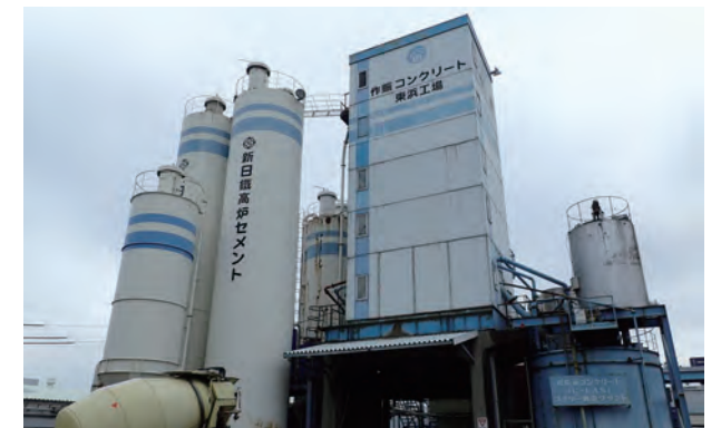
写真1 (株)作販コンクリート東浜工場のBP
