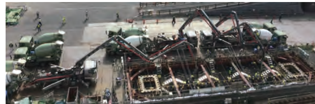
写真7 コンクリート打込み状況(途中段階)
