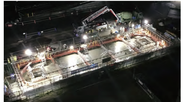
写真8 コンクリート打込み状況(完了間近)
