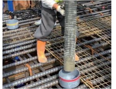
写真6 コンクリートポンプ車の筒先挿入状況
