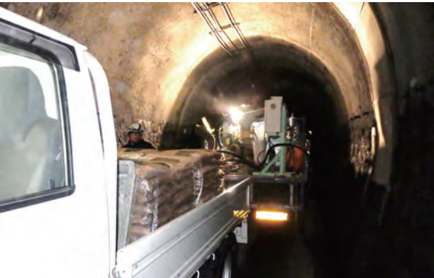
写真9 トンネル内に設置した車両
