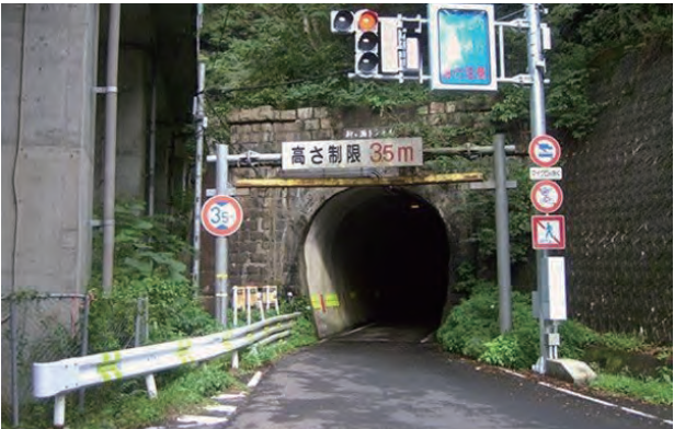
写真8 柳ヶ瀬トンネル外観
