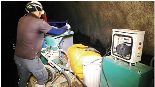
写真10 車上プラントでの作業状況
