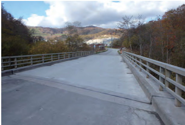
写真3 供用後の状況
