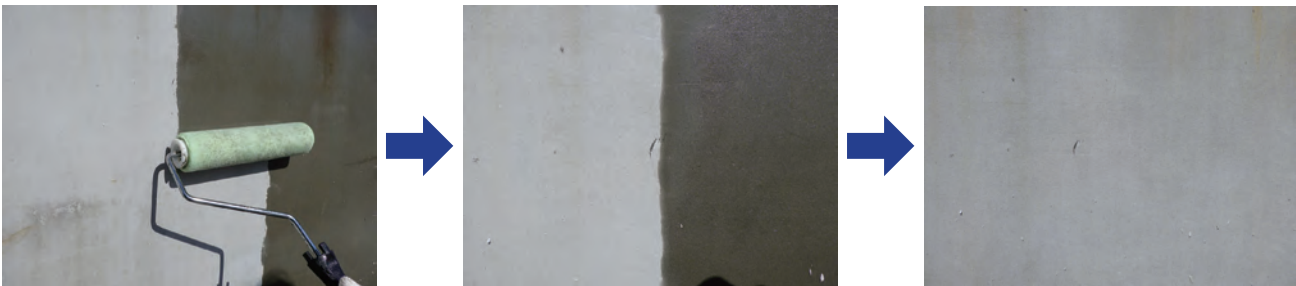
写真2 塗布後の状況
