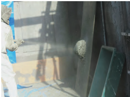
写真4 厚付け性試験状況
