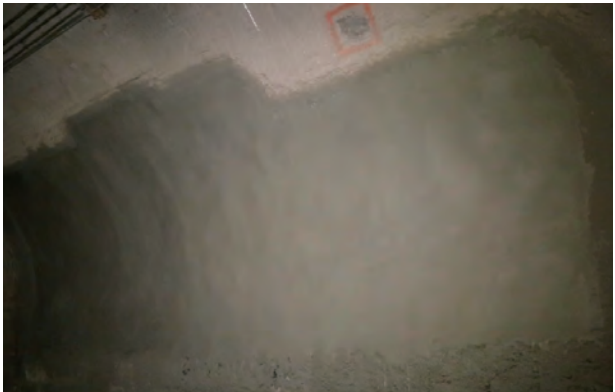
写真12 仕上げ後の状況
