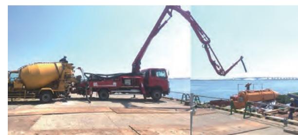
写真6 コンクリートの積み替え
