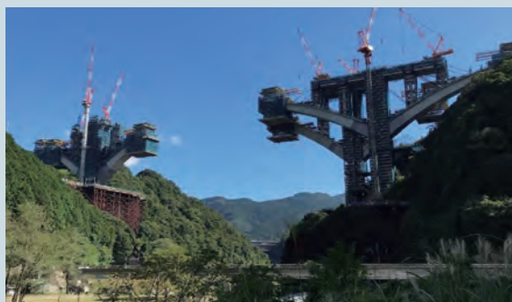
バランスドアーチ橋のアーチリブ張出し架設におけるコンクリート施工 -新東名高速道路 河内川橋(仮称)
