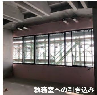
写真5 ダクト施工状況
