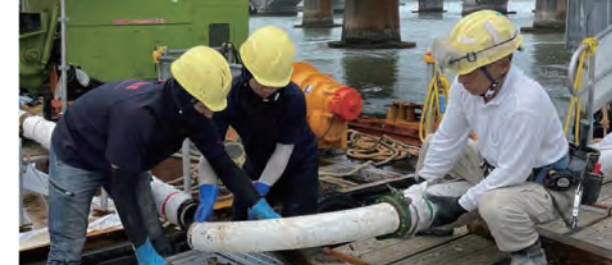
写真7 コンクリート打設資機材
