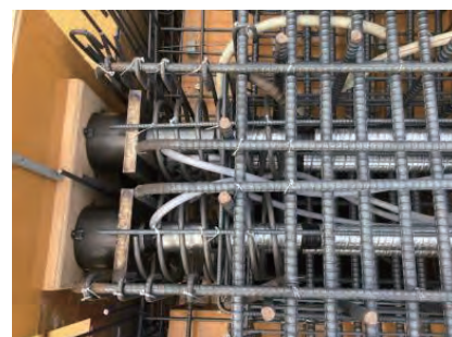
写真 8 柱頭付近の定着具納まり状況
