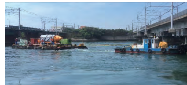
写真5 コンクリート台船による曳航
