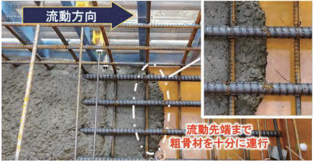
写真3 流動先端状況
