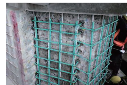
写真3 撤去したコンクリートと新設鉄筋
