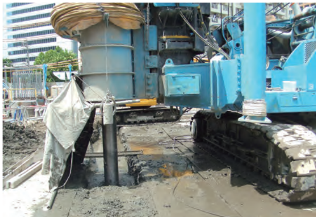
写真5 ソイル柱列式連続壁工法
