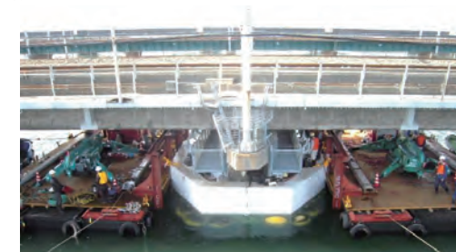
写真4 仮締切設置作業状況
