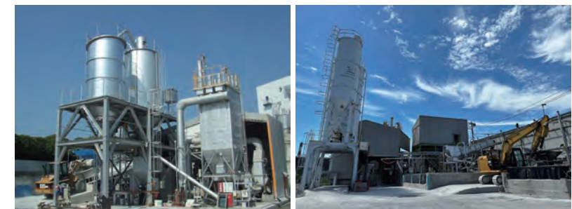
写真1 スラッジ再生セメント製造プラント [左：藤沢市 右：川崎市]
