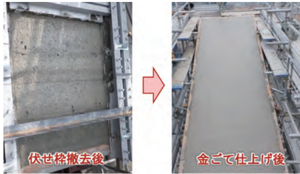
写真3 伏せ枠撤去後の表層状況
