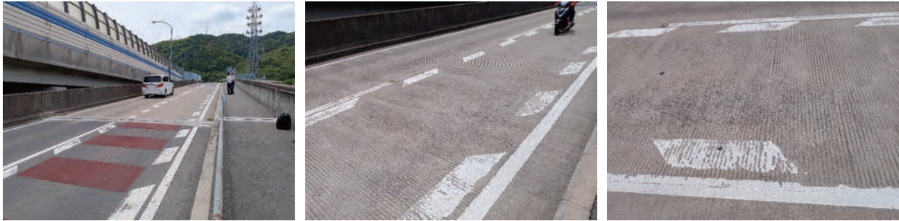
写真17 供用中の試験施工箇所(2023年6月7日)
