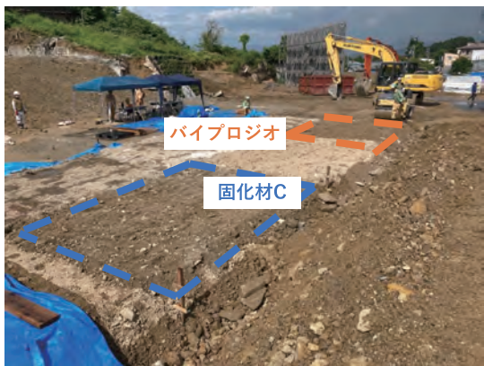
写真3 試験盛土完成状況
