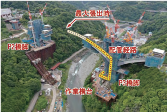
写真1 河内川橋工事の現況(上流側から望む)
