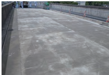
写真13 施工終了(2016年8月10日)
