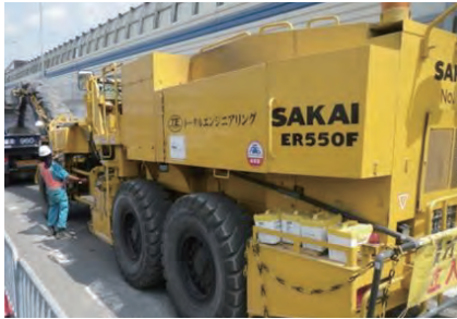
写真2 既設アスファルト舗装切削工
