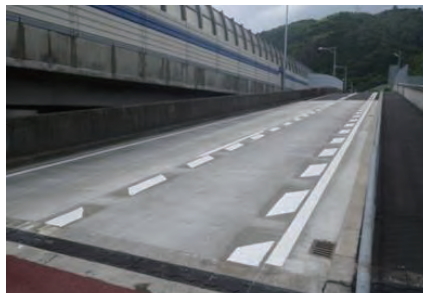
写真14 供用中(2016年9月3日)
