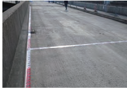
写真3 既設アスファルト舗装切削後
