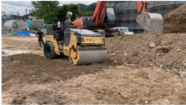
写真2 試験盛土の転圧状況
