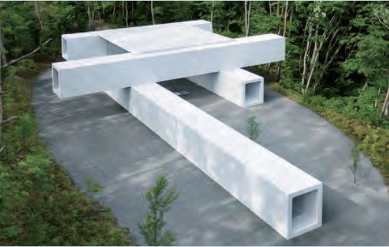
PCaボックスカルバートによる居住空間の創出
