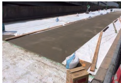
写真12 養生工(上り車線と下り間詰、下り車線は養生終了)
