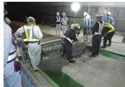
写真9 接着剤塗布および打込み
