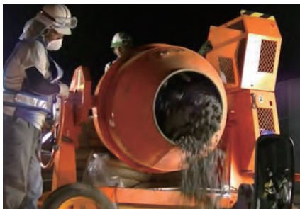
写真7 コンクリートの練混ぜ
