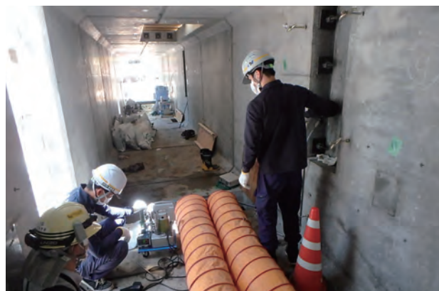
写真10 緊張状況(ボルトテンショナー)
