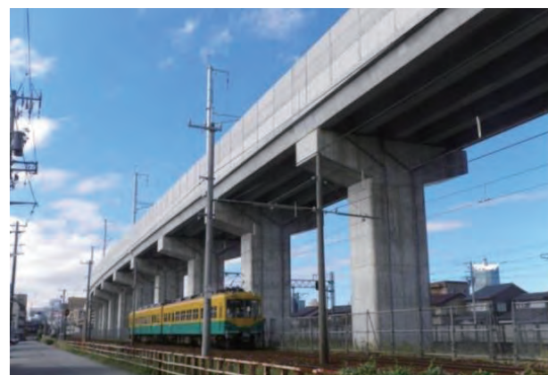
写真1 PCU形桁 [北陸新幹線 稲荷千歳高架橋]
