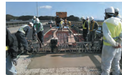
橋梁床版の補強材（現場）
