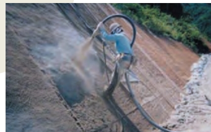
法面モルタル吹付け（現場）
