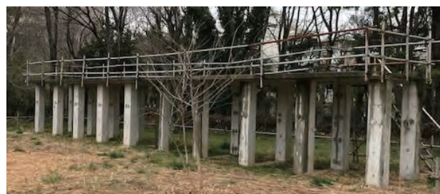
写真1 中規模RCラーメン模擬高架橋 12)
