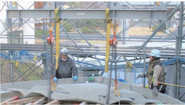
写真3 3DP製デッキの建方
