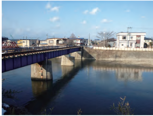
写真6 復旧完了後全景写真
