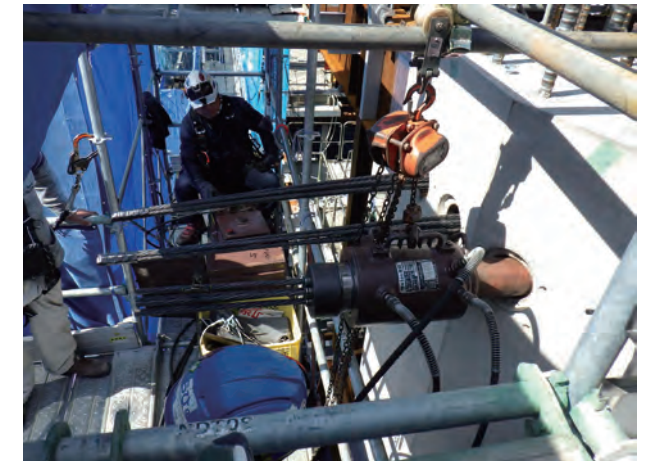
写真8 緊張工事の状況
