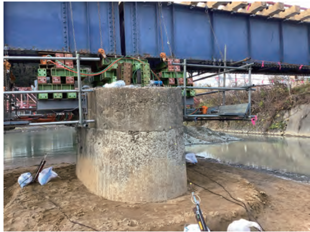
写真3 ブラケット・サンドルによる仮支承
