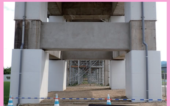
RC柱部材の軸方向鉄筋にフレア溶接継手を配置して復旧した鉄道RCラーメン橋台
