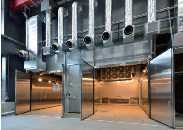
写真7 多目的人工気象再現室の外観
