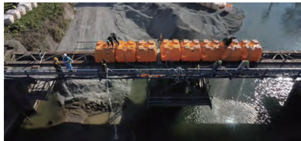
写真4 水タンクによる試験状況
