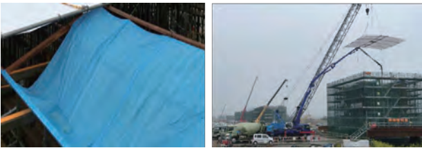
写真1 シートによる降雨対策の例
