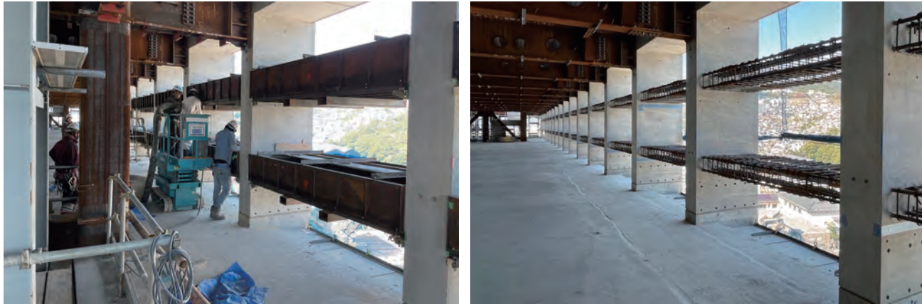
写真9 階中間梁の施工状況
