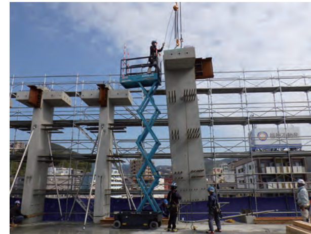
写真7 PCaRC 柱ピースの架設状況
