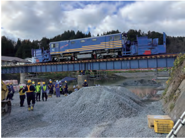
写真5 載荷試験状況(投排雪保守用車)
