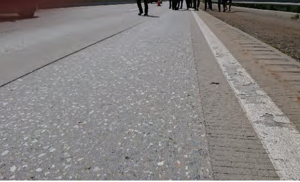
写真6 路面の研削状況
