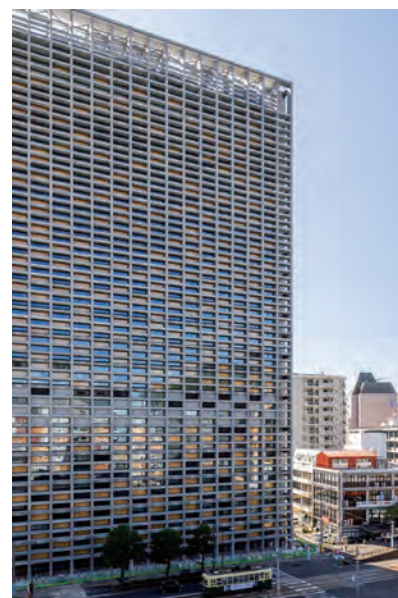
写真2 RC柱梁とCLTパネルによるファサード
