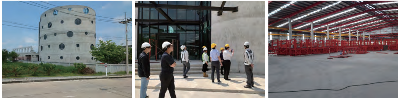
写真8 STEELFORMER社にて [スリップフォーム工法によってつくられた建物(左)と見学の様子(中央)、作製中の型枠(右)]
