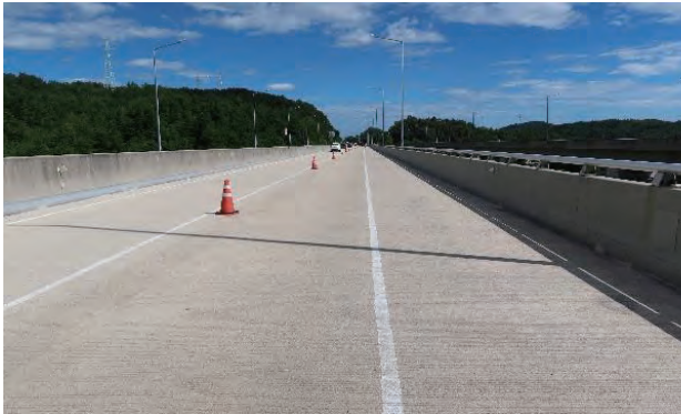
写真5 LMC bridge deck pavement 5)
