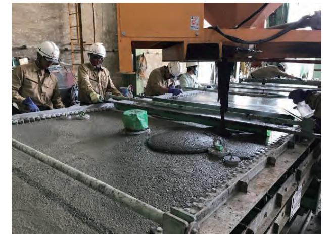
写真3 スリムクリートの打込み状況
