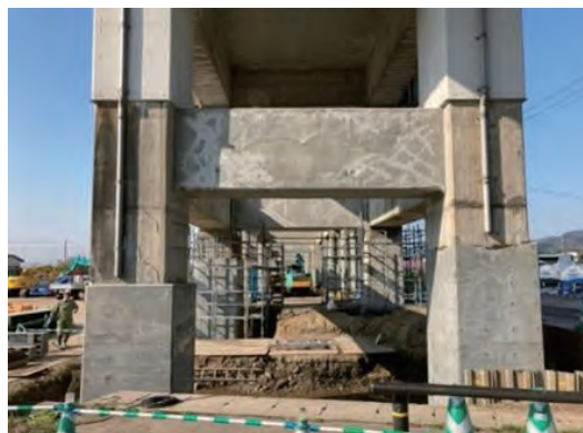
写真1 RC柱部材の復旧状況
