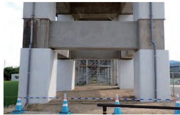
写真2 鋼板巻き立て耐震補強完了状況
