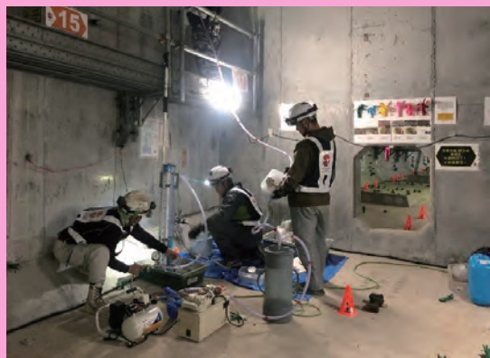
阪和自動車道土丸橋(上り線)のPCグラウト再充填工事
