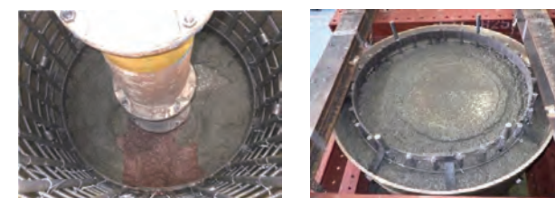
写真1 コンクリートの打込み状況
