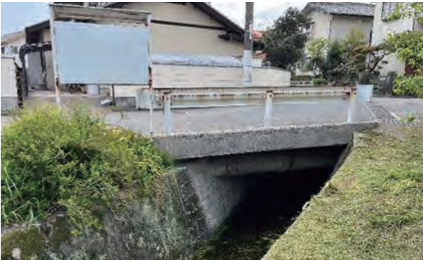
写真3 対象構造物の例 (可愛ヶ丘1号線跨線橋: 廿日市市)
