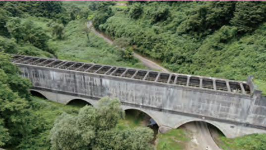
信濃川発電所第3期真人沢水路橋におけるAEコンクリートの品質調査
