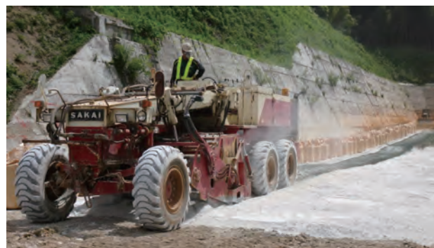
写真3 重機を用いた吸着層施工の様子
