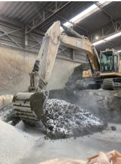
写真1 土壌への不溶化材の添加・混合
