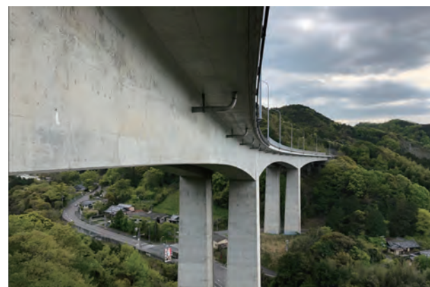
写真1 土丸橋(手前：上り線)
