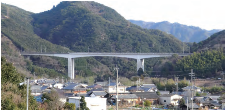
写真7 補修工事完了後
