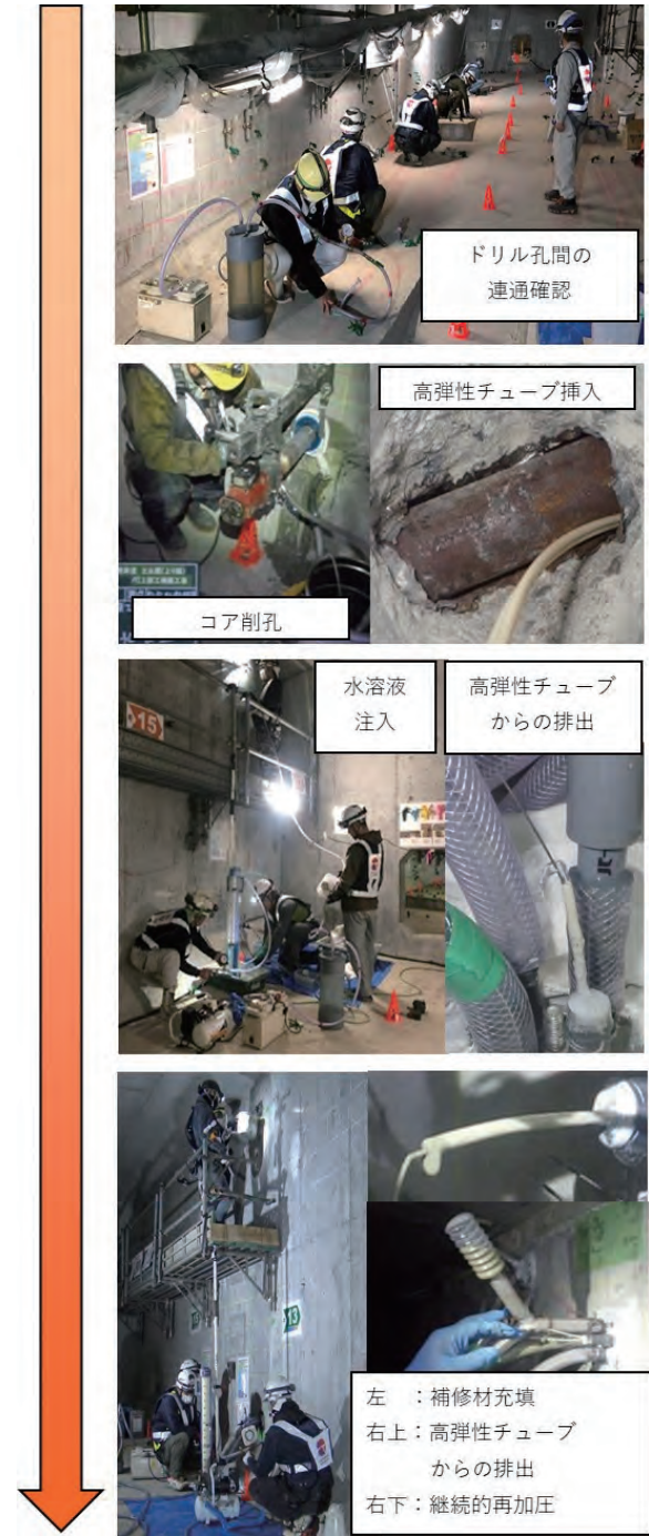
写真6 再充填工の手順
