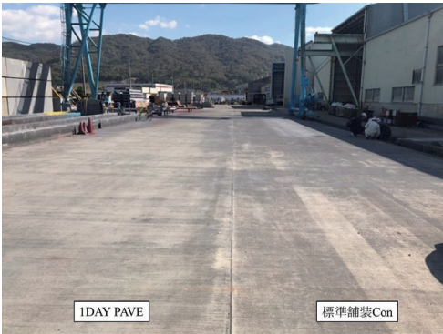
写真3 舗装完成状況
