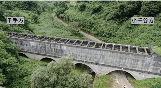
写真1 第3期真人沢水路橋全景
