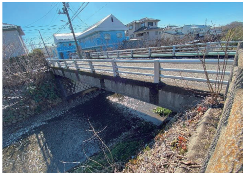
写真4 浅山橋(1974年竣工)
