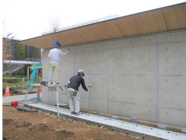
写真2 クリヤ塗装の施工状況
