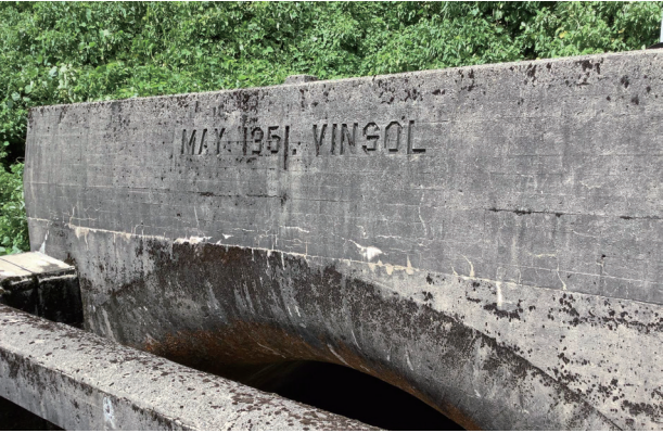
写真2 壁高欄壁面の刻印(VINSOL)
