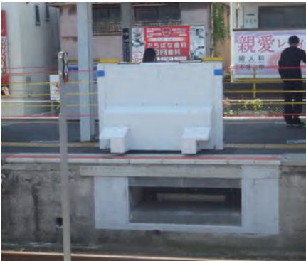
写真11 ホーム柵設置状況
