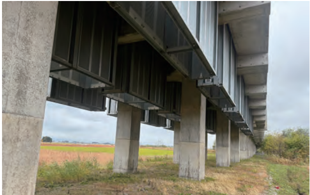
写真1 吊下げ式防音壁の試験状況
