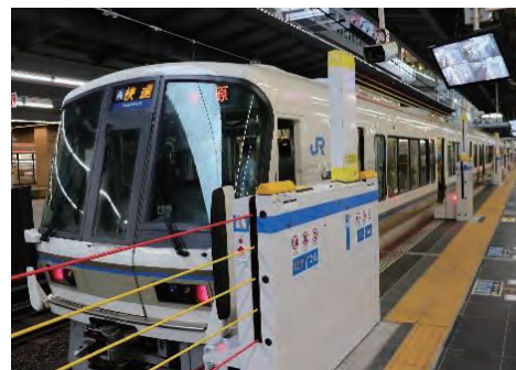
写真2 昇降式ホーム柵
