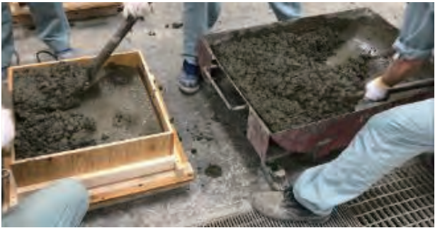
写真4 普通コンクリート打設状況
