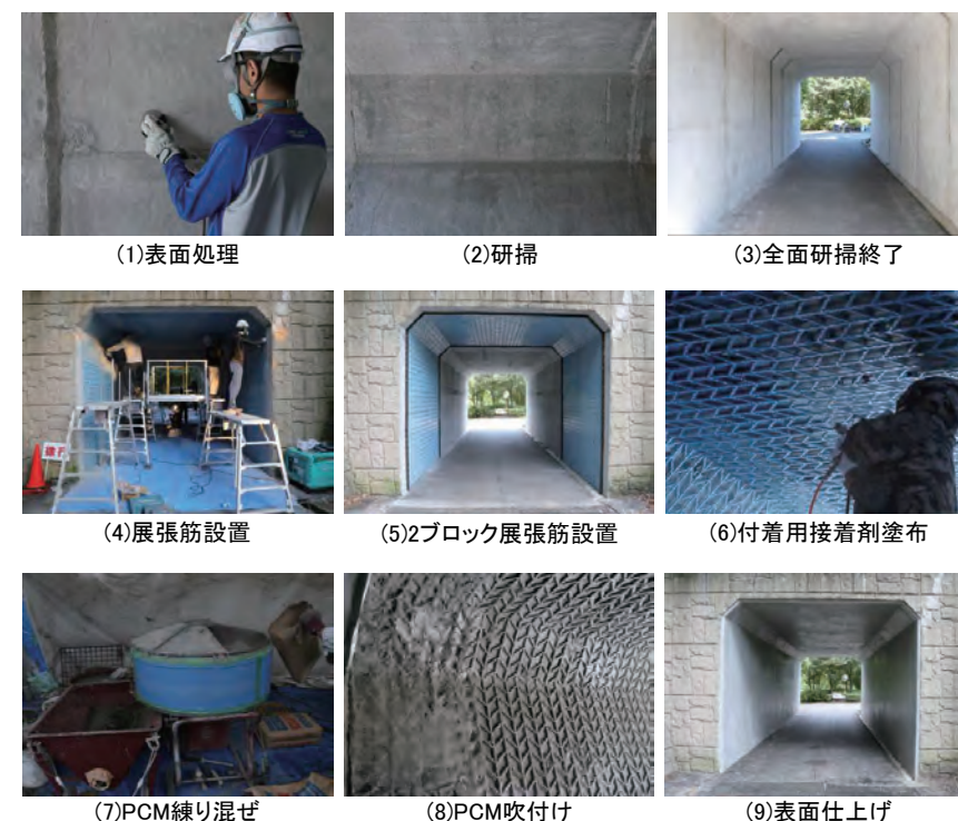
写真8 カルバートの施工手順
