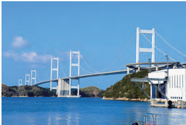
▲規模の異なる3つの吊橋が一体となって見えるよう、6本の塔頂を結んで一つの滑らかな曲線になるように塔高を連続的に変化させている。
