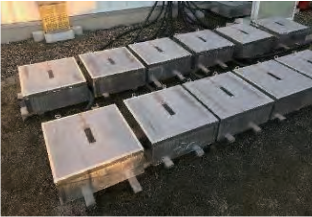
写真5 屋外暴露状況
