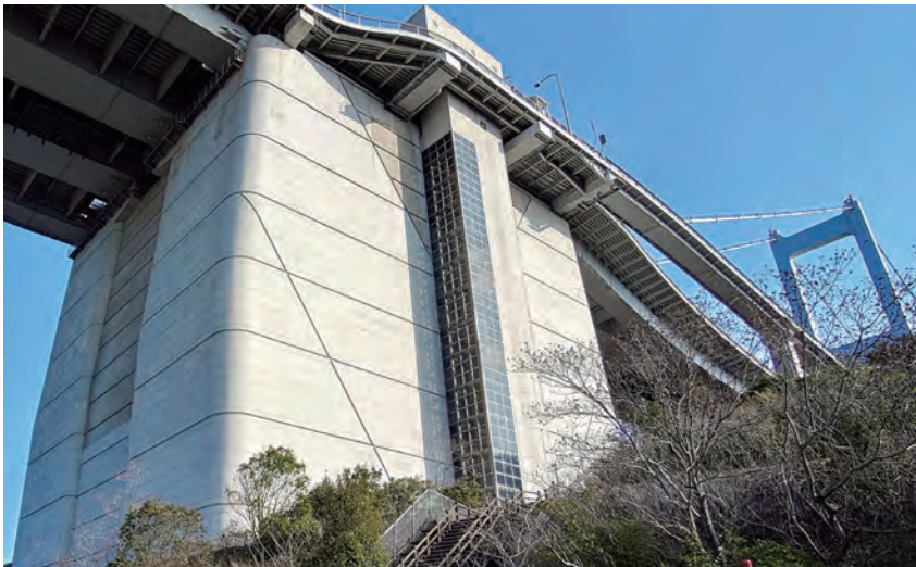
▲馬島にある7Aアンカーブロック。幅42m×長さ52m×高さ62m、使用コンクリート量約9万m 3 。側面に設置されたエレベーターは島内住民の他、一般の自転車や歩行者等も利用できる。
