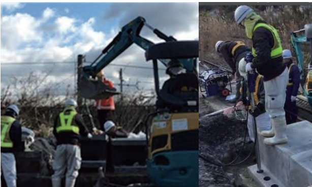
写真6 施工性の確認試験の状況(基礎設置, 杭打設)
