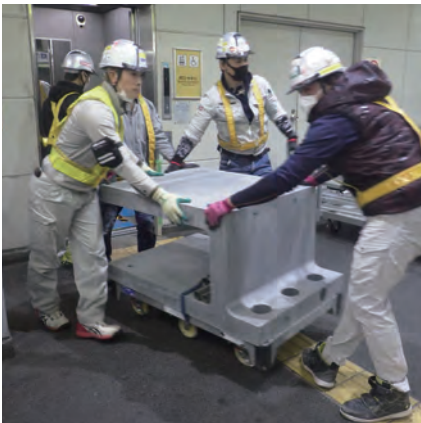
写真8 C型ブロックの運搬状況(エレベータを使用)
