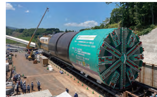
写真2 SENS掘削マシン
