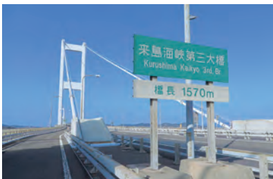
▲上写真 来島海峡第三大橋の橋脚
