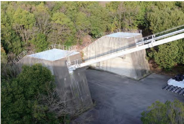
▲地形変化が最小限にできるトンネル式アンカーを採用した今治側10Aアンカレイジ。
