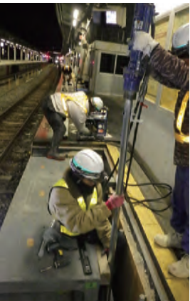
写真10 小径杭の打設状況
