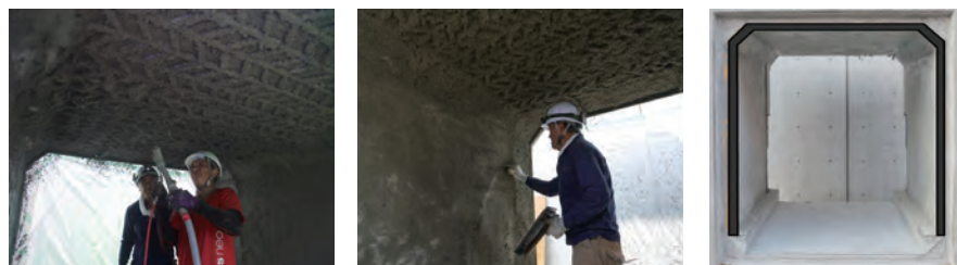
(4) PCM吹付け (5) コテ仕上げ (6) 完成
