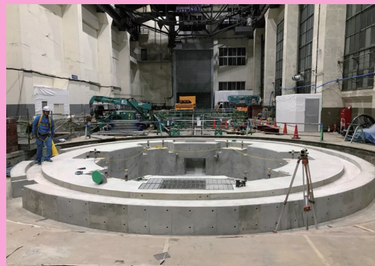
信濃川発電所(千手発電所)老朽化設備取替に伴う水車発電機基礎コンクリート工事
