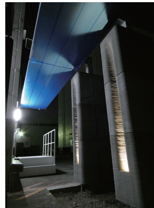
写真8 支柱外枠 [大成建設提供]
