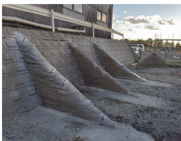
写真2 乾式吹付システムとICTバックホウとの組合せ [住友大阪セメント提供]
