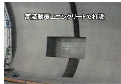
写真7 箱抜き箇所における高流動覆工コンクリートの充填状況
