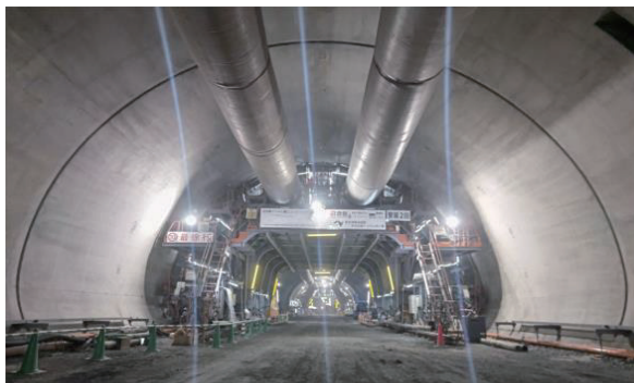
写真5 高流動覆工コンクリートの仕上がり
