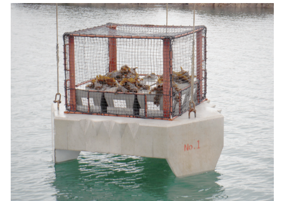
写真8 沈設作業中のコンクリート藻場増殖礁
