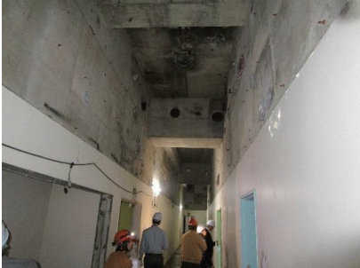
写真2 再利用する既存地下躯体の内観(補修前)
