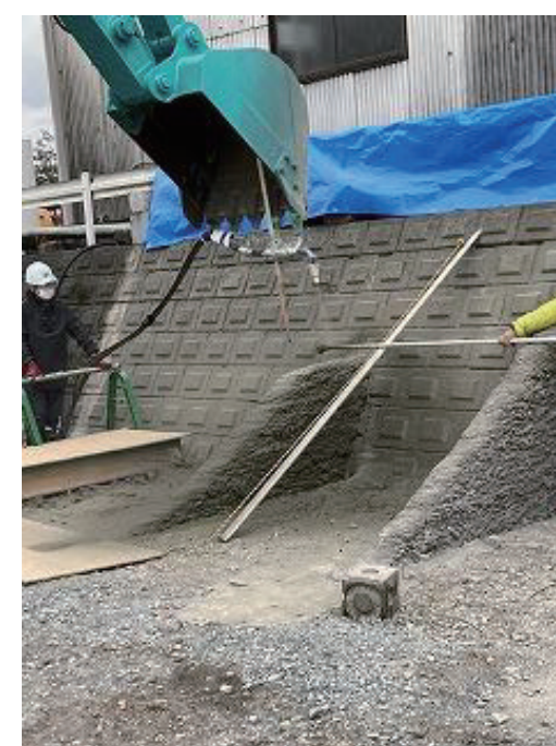
写真2 乾式吹付システムとICTバックホウとの組合せ [住友大阪セメント提供]
