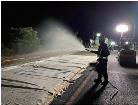
(d)散水養生
