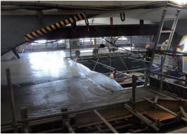
写真8 ケーシング部基礎新設完了
