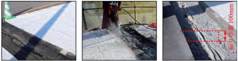
(1)旧伸縮装置および養生 (2)はつり作業 (3)はつり完了
