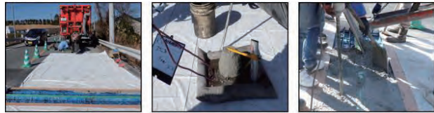
写真8 超速硬コンクリートの打ち込み
