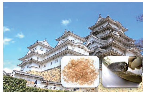
写真5 白壁／漆喰壁(麻スサ)
