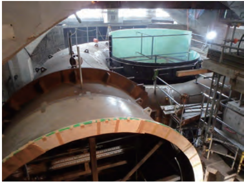
写真1 ケーシング部基礎新設着手前
