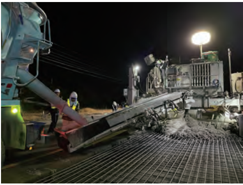
(a)コンクリートの打込み
