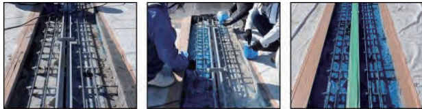
写真7 流動性モルタル充填完了および付着用接着剤の塗布
