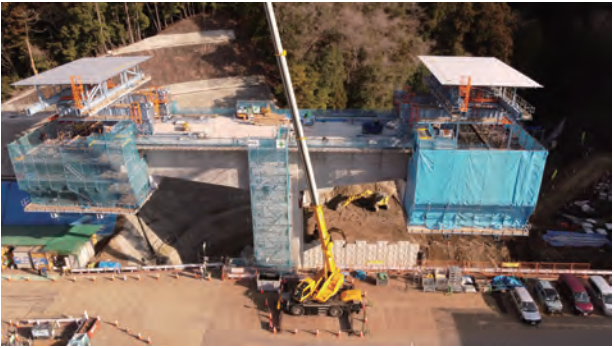
写真6 張出し架設状況
