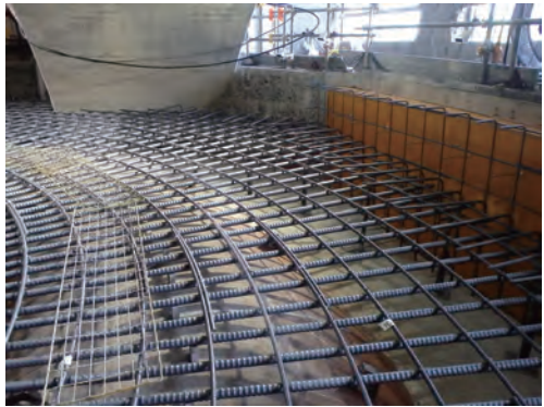
写真3 ケーシング部配筋状況
