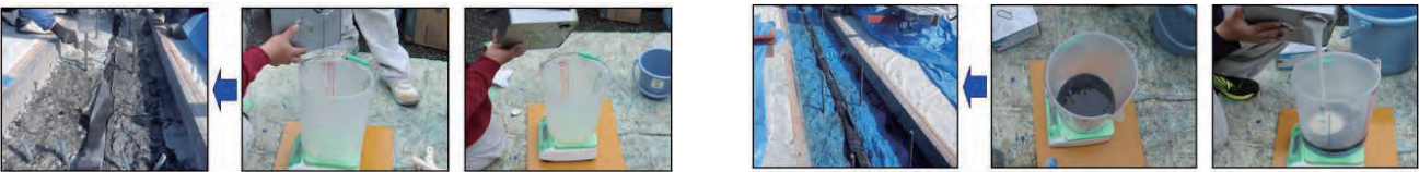
(1)浸透性接着剤の塗布 (2)浸透性接着剤の混合 (2)付着用接着剤の塗布 (2)付着用接着剤の混合
