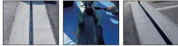
写真9 表面仕上げおよびSM止水材の充填
