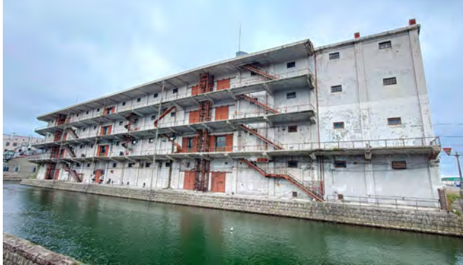
▲第3倉庫(左:運河側、右:海側)
