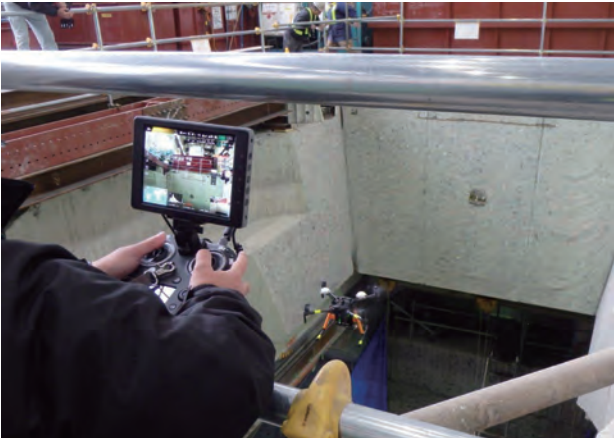
写真9 ドローンによる副梁部切断面調査
