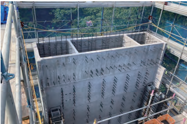
写真4 鉄筋ジベル施工状況
