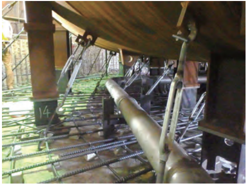
写真2 ケーシング下部状況
