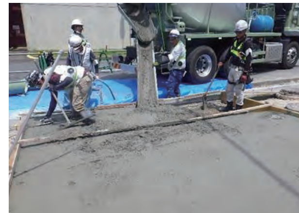
写真10 リカボクリート®の打込み
