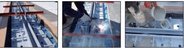
(1)伸縮装置の設置 (2)アンカー筋の溶接 (3)流動性モルタル充填
