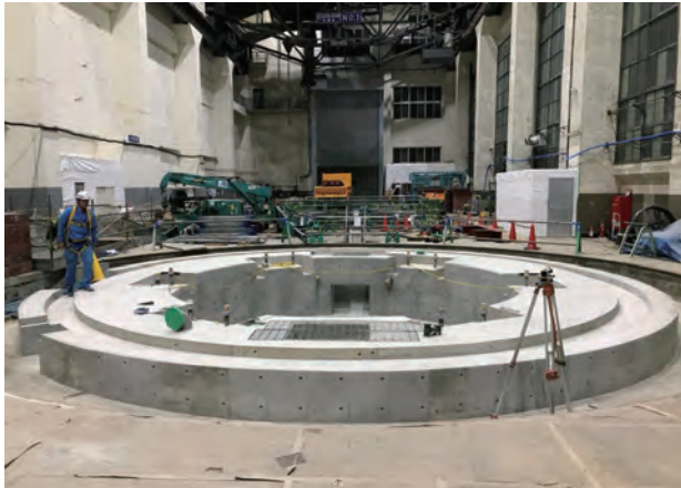
写真11 副梁部基礎新設完了
