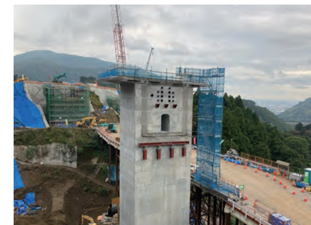
写真3 柱頭部施工完了状況
