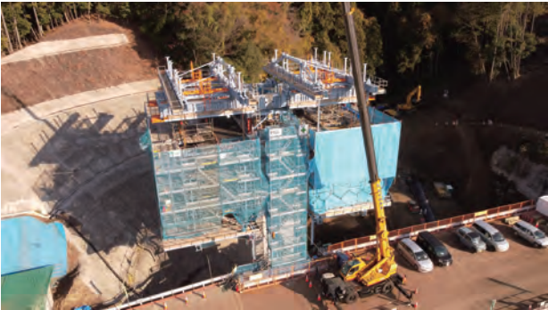
写真5 0ブロック施工状況
