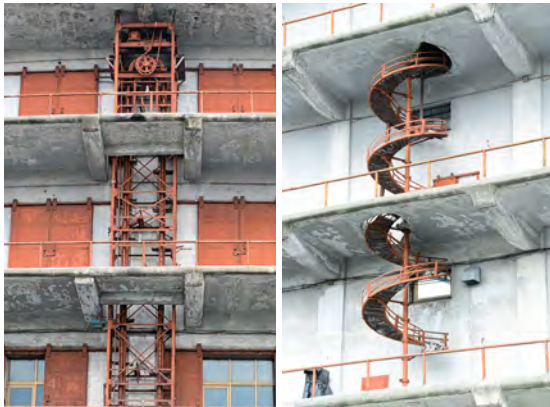
▲運河側に運搬用設備を集約(左:エレベーター(リフト)、右:スパイラルシュート)
