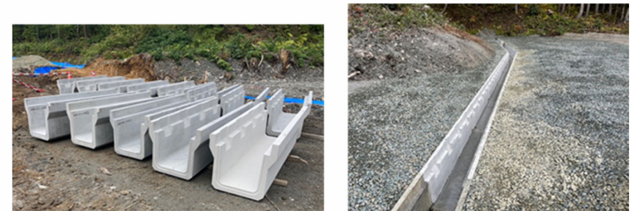
<直轄工事現場に設置されたU字溝>
