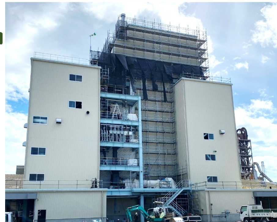
CO 2 回収型セメント製造設備(C2SPキルン ® )の実証機建設状況
