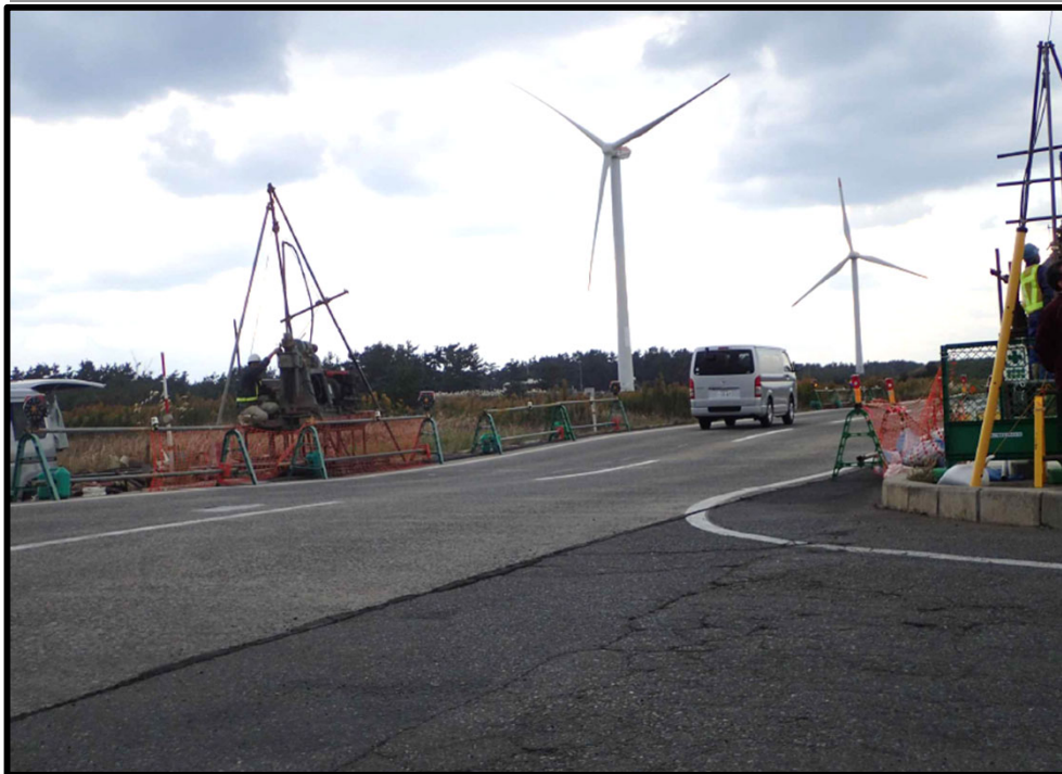
地震により不等沈下しても通行可能であった国道9号北条バイパス
