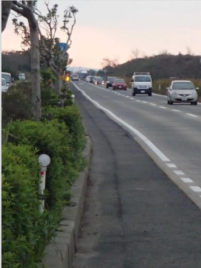
鳥取県中部地震(震度 6 弱)で被災した国道 9 号北条パイパスのコンクリート舗装 (側道のアスファルト舗装は 10cm 以上の段差が発生した)
