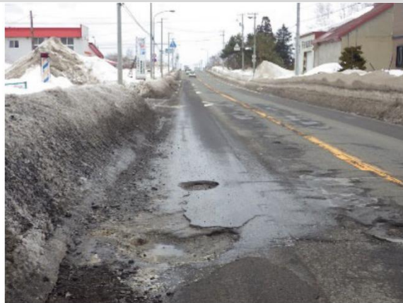
北海道開発局から示されたポットホールの様子 (道路行政セミナー2024.4 資料より)
