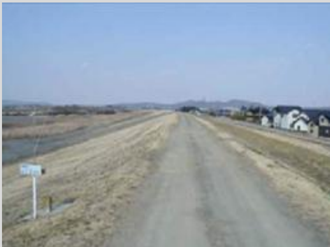
地盤改良区間は健全
