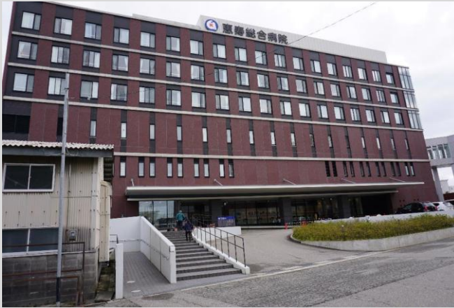
被災直後の医療施設全景
