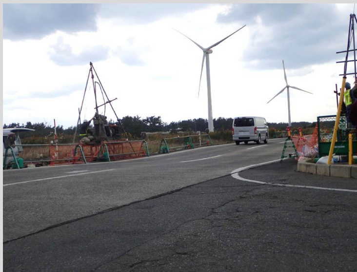
鳥取県中部地震(震度 6 弱)で被災した国道 9 号北条パイパスの連続鉄筋コンクリート舗装 (側道のアスファルト舗装は 10cm 以上の段差が発生した)
