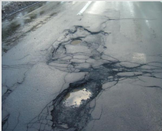
北海道開発局から示されたポットホールの様子 (道路行政セミナー2024.4 資料より)
