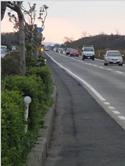
鳥取県中部地震（震度 6 弱）で被災した国道 9 号北条パイパスの連続鉄筋コンクリート舗装 （側道のアスファルト舗装は 10cm 以上の段差が発生した）
