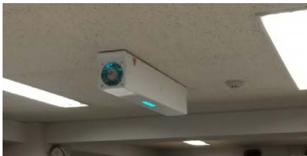
写真3 本社事務所への紫外線殺菌灯 B-ZOON 設置の様子
