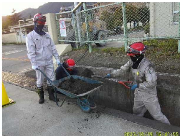
写真7 正門前側溝清掃
