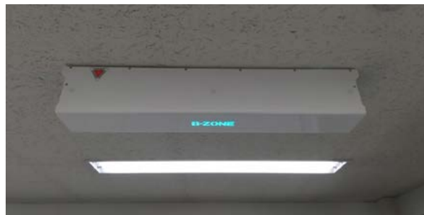
写真3 本社事務所への紫外線殺菌灯 B-ZOON 設置の様子
