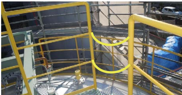
写真15 今回の審査における改善指示の一例（取り外し可能なチェーンの追加）
