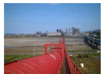
写真6 CBC (ケーブルベルトコンベヤ)
