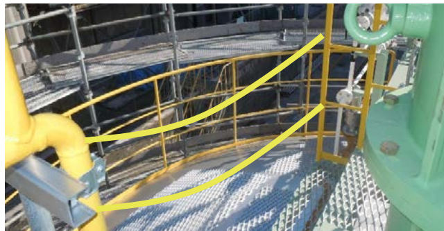
写真15 今回の審査における改善指示の一例（取り外し可能なチェーンの追加）
