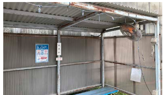
写真2 ミスト散水を設置した屋外休憩所
